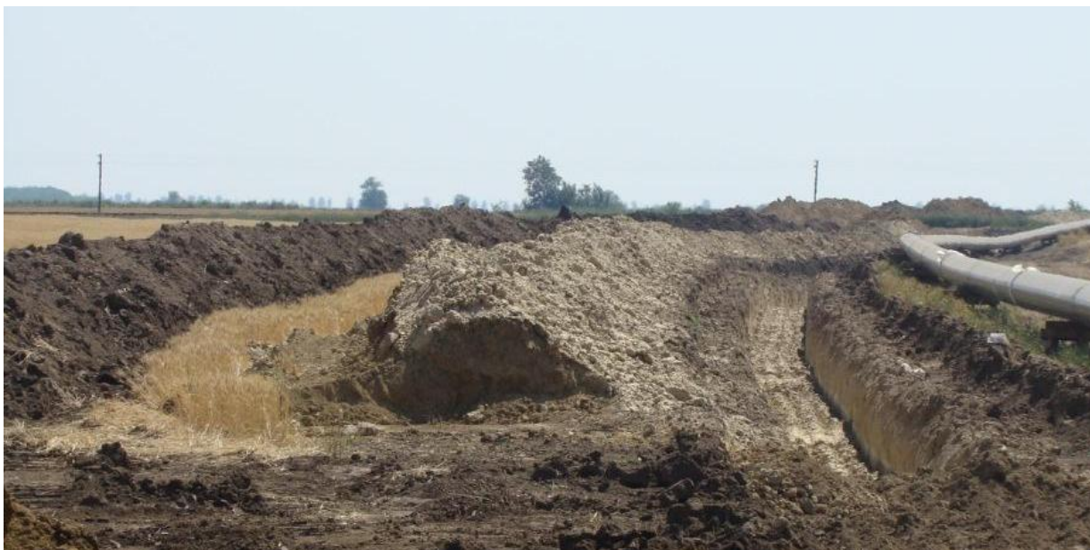
Fig.1.VIII. Aspectul unui culoar de lucru pentru amplasarea unei conducte de transport gaze naturale
