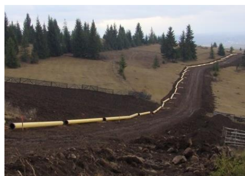
Fig.1.XIII. Segmente de țevă înșirate în lungul șanțului
