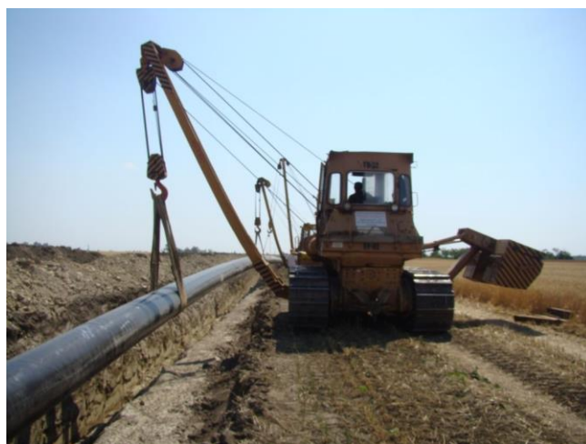
Fig. 1.IX. Etapa de lansare a conductei de transport gaze naturale schematic (stânga) și aspect de la nivelul unui șantier (dreapta)
