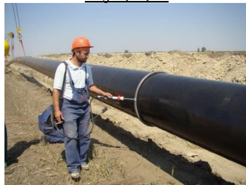
Fig.1.XIV. Verificarea izolației înaintea lansării conductei în șanț
