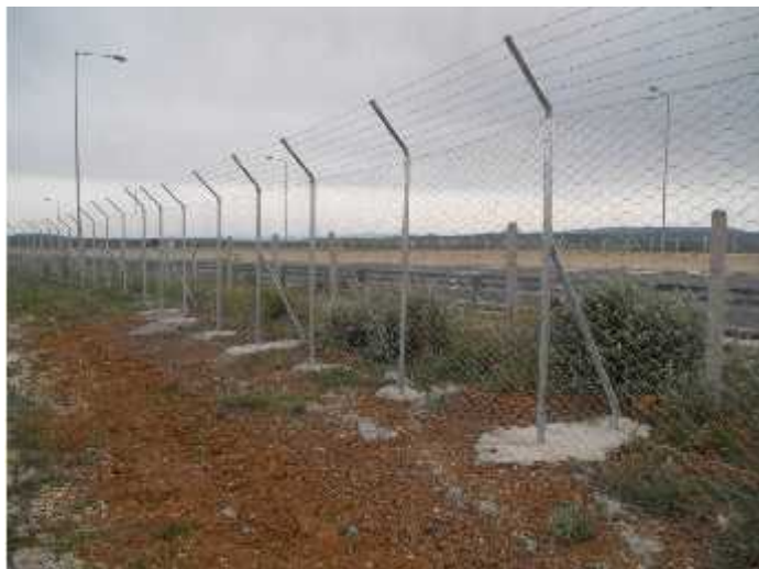
Figura 15. Imprejmuire pentru limitarea accesului pe autostrada a speciilor de carnivore mari si mamifere
