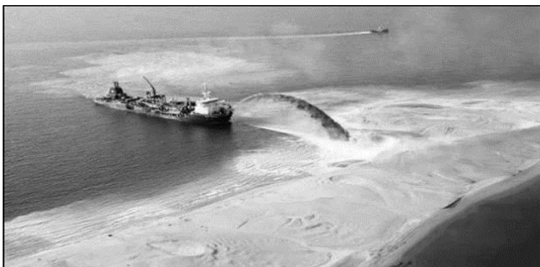
Figura 2.4-7 Dragare prin aspiratie si taiere
