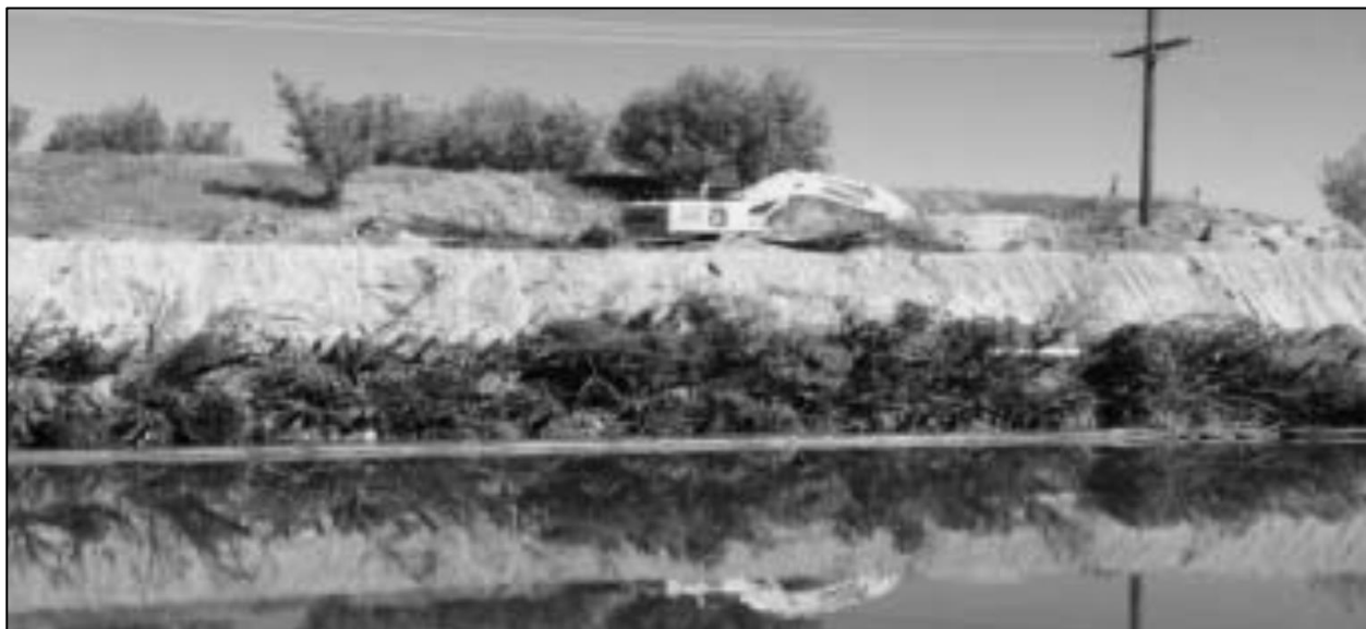
Figura 2.4-14 Exemplu de mal inierbat: arbusti si busteni pe o fundatie mica de anrocamente, cu material lemnos mort si butasi vii la nivelul apei; protectia malurilor si crearea diversitatii habitatelor
