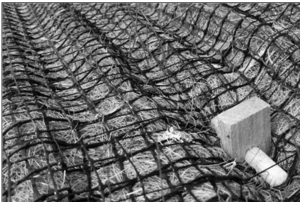
Figura 2.4-12 Protectie eroziune mal cu geotextil
