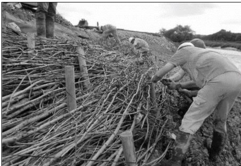
Figura 2.4-10 Instalare fascine
