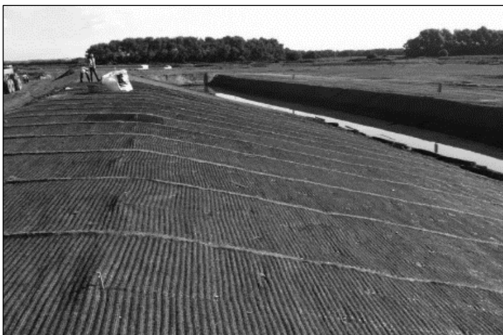
Figura 2.4-13 Protectie eroziune mal cu geotextil
