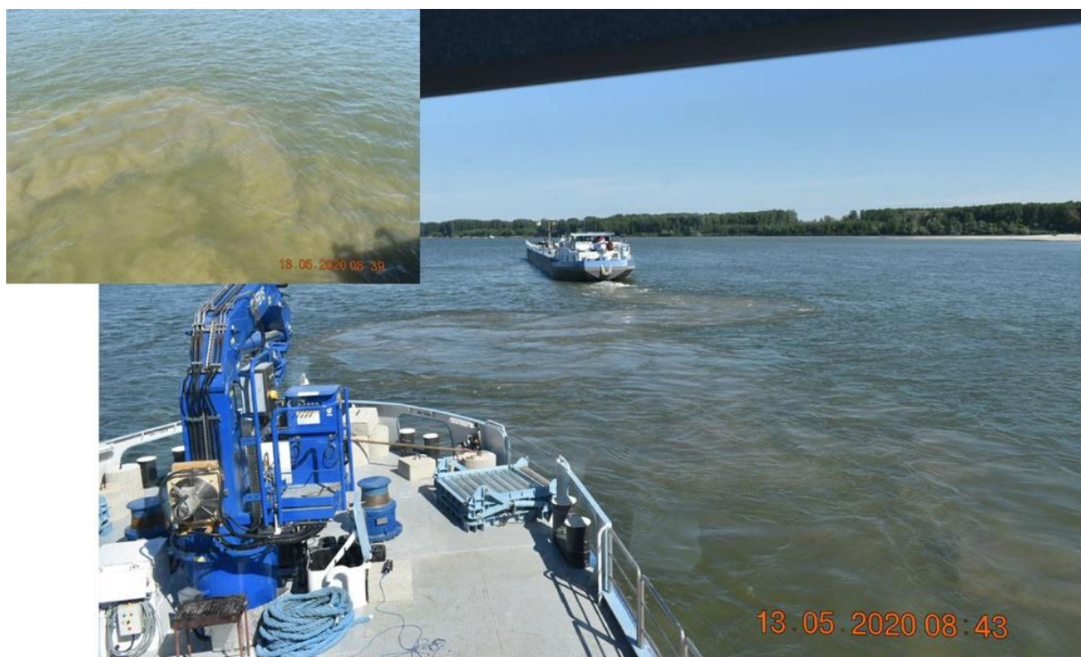
Figura 5.2-13 Observarea vizuala a penei de sedimente, in timpul dragarii
