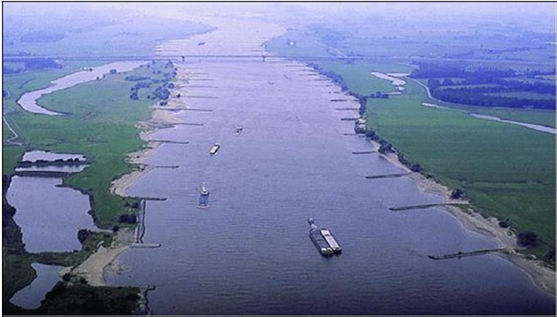
Figura 7.2 Raul Waal (Tarile de Jos): o ramura a fluviului Rin: s-a indreptat progresiv si ingustat cu 30 % cu ajutorul unor epiuri fluviale incepand cu anii 1850
