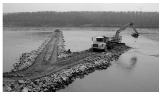
Figura 2.12-5 Dragarea prin aspiratie cu dizlocare (stanga) si constructia caii de acces (dreapta)
