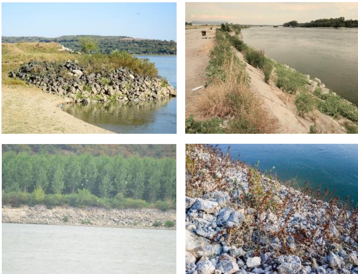
Figura 4.1-13 Aspecte ale apararii tarmurilor pe care au fost instalate plante invazive, observate in teren in punctele critice Corabia, Belene si Kosui
