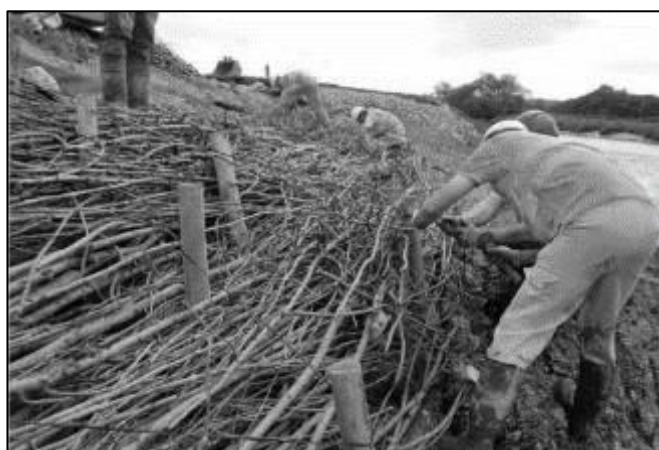
Figura 2.12-7 Instalarea fascine (stanga) si fascine tipice (dreapta)
