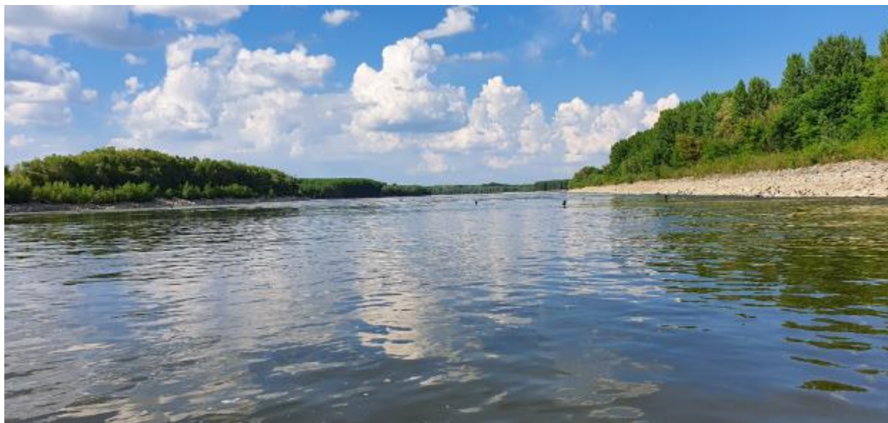
Figura 4.1-12 Aspecte ale stabilizarii malurilor realizate in cadrul proiectului "Imbunatatirea conditiilor de navigatie pe Dunare intre Calarasi si Braila si masuri complementare", pe care as-a instalat Amorpha fruticosa , pe bratul Bala, in zona km 10 (sursa: arhiva personala)
