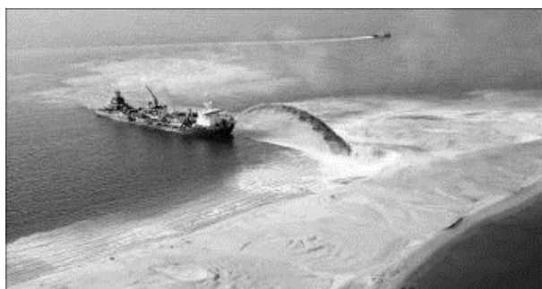
Figura 2.12-5 Dragarea prin aspiratie cu dizlocare (stanga) si constructia caii de acces (dreapta)
