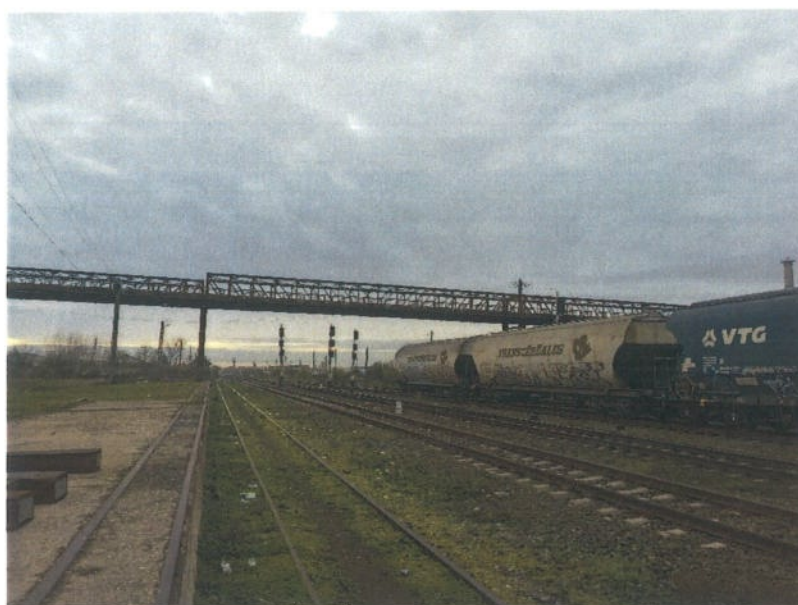
Figura 3.6.1-20 Pasarelă pietonală metalică
