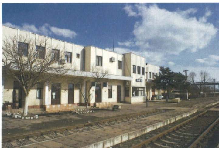
Figura 3.6.1-10 Starea actuală a clădirilor de cale ferată
