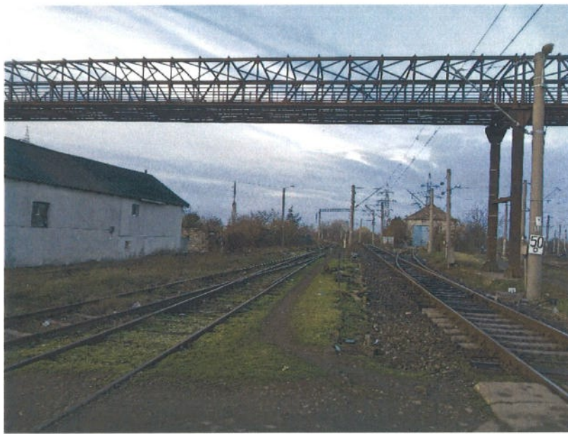
Figura 3.6.1-18 Pasarelă pietonală metalică
