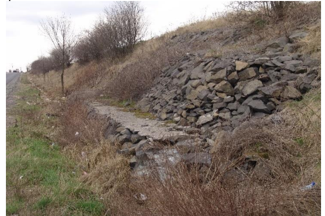
Figura 48 Utilizarea de bolovănișuri ca microhabitate este în măsură a oferi nișe suplimentare ecologice (stânga) și funcționând ca zone de drenaj a apelor de spălare ce contribuie substanțial la stabilizarea pantelor (dreapta)
