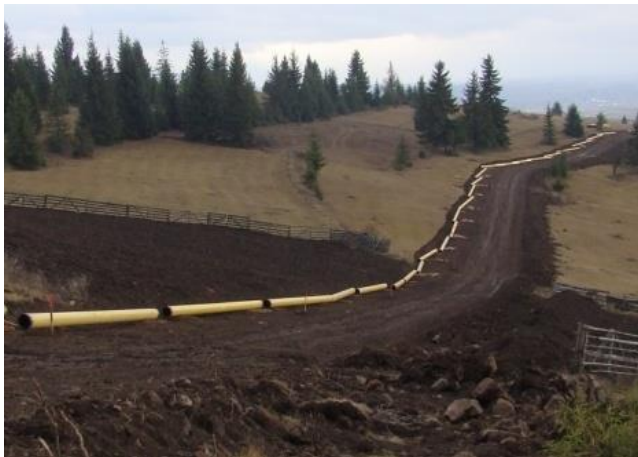
Figura 23 Segmente de țevă înșirate în lungul șanțului (stânga); Verificarea izolației înaintea lansării conductei în șanț (dreapta)
