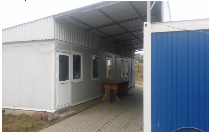
Figura 9 Model de organizare de șantier realizată din containere mobile
