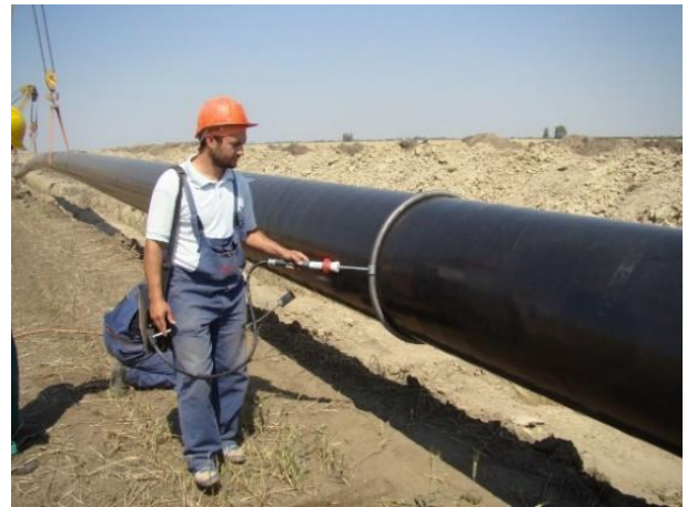
Figura 23 Segmente de țevă înșirate în lungul șanțului (stânga); Verificarea izolației înaintea lansării conductei în șanț (dreapta)
