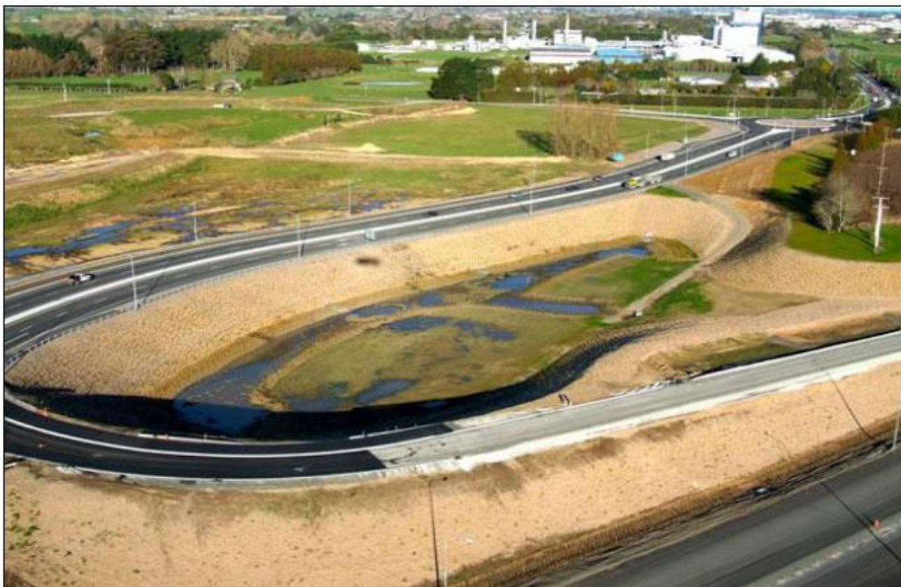
Fig.4.II.Bazin decantor de la nivelul unei bretele de autostradă [Chalmers Univ. of Tech. 17 ]
