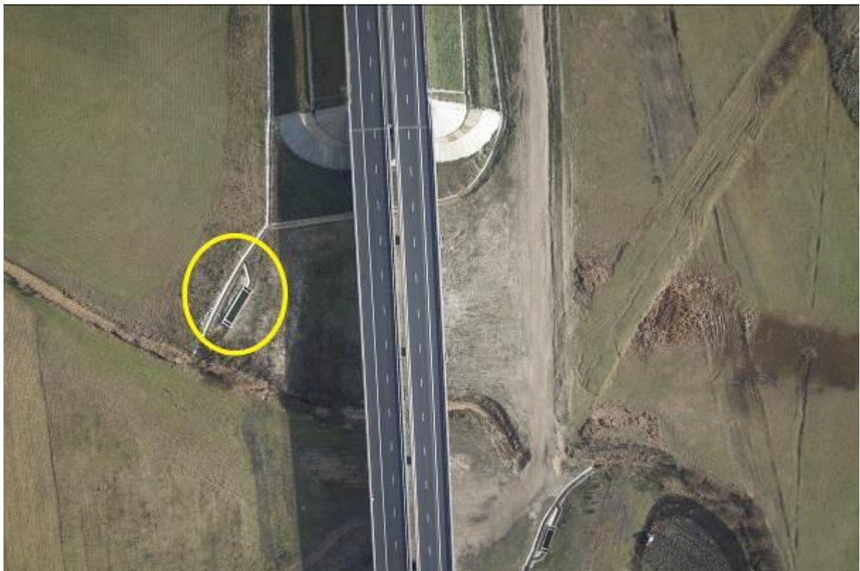
Fig.1.IX B.Bazin decantor cu separator de hidrocarburi existent în lungul sectorului 2B Câmpia Turzii - Gilău
