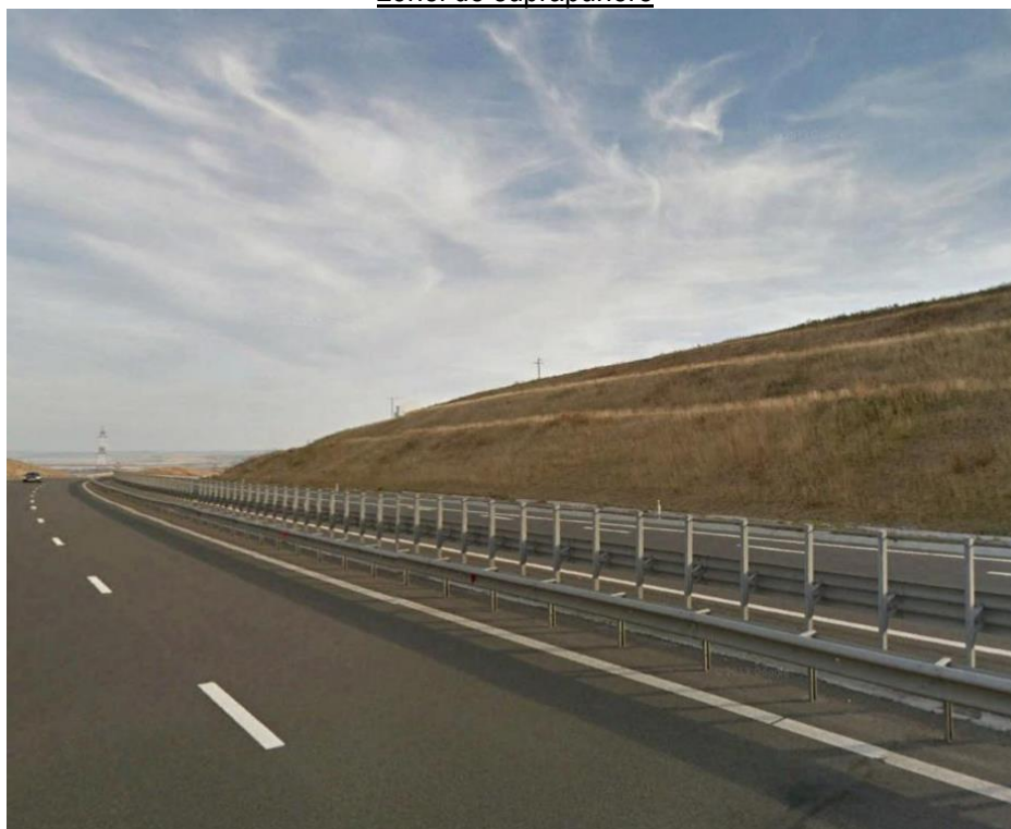
Fig.2.XX.Aspect din zona culoarului de conexiune ce intersectează traseul sectorului de autostradă Câpia Turzii – Gilău, dat în exploatare în anul 2009
