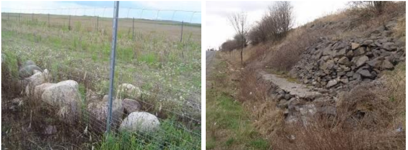
Fig. 4.III. Utilizarea de bolovănişuri ca microhabitate este în măsură a oferi nişe suplimentare ecologice (stânga) şi funcţionând ca zone de drenaj a apelor de spălare ce contribuie substanţial la stabilizarea pantelor (dreapta)
