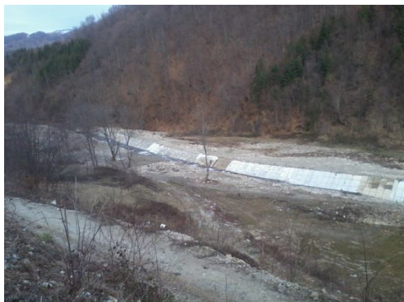
Figura 9 Aval baraj râul Hălmăgel
