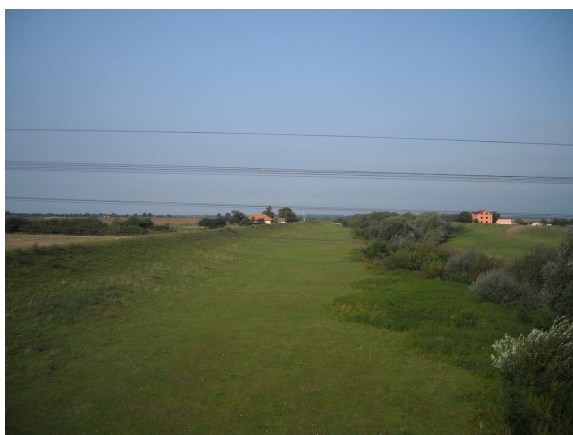
Figura 63. Dig pe malul stâng al râului Barcău
