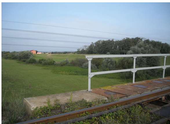
Figura 45. Pod cale ferată ce traversează râul Barcău în cadrul ROSPA0067 Lunca Barcăului
