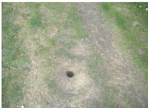
Figura 46. Galerie de popândău pe coronamentul digului de pe malul drept al râului Barcău
