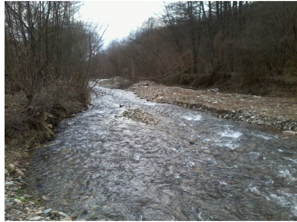
Figura 4. Comuna Hălmăgel Amonte uzina de apă a comunei
