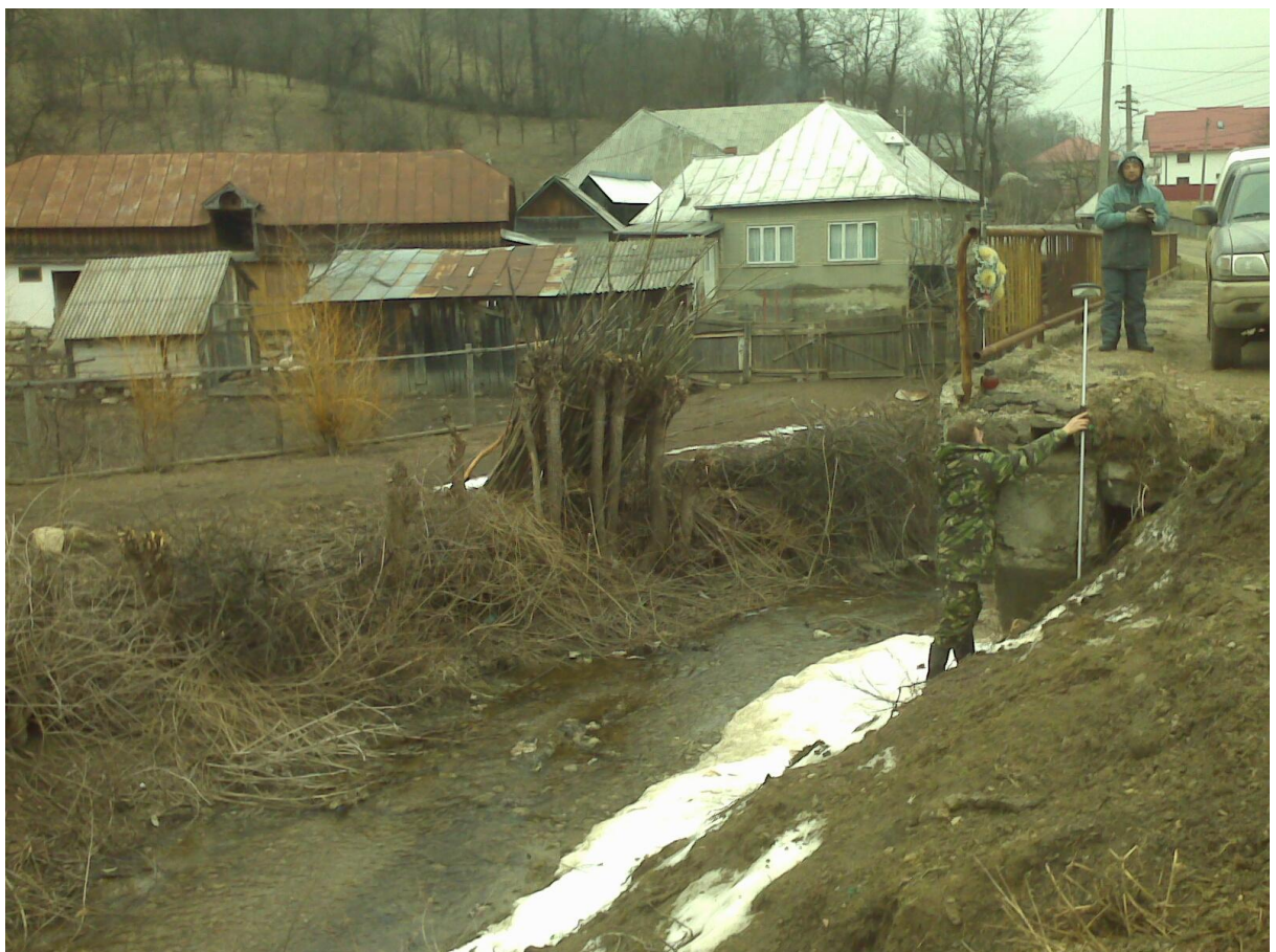
Figura 3.2-8 Activități de măsurători topografice
