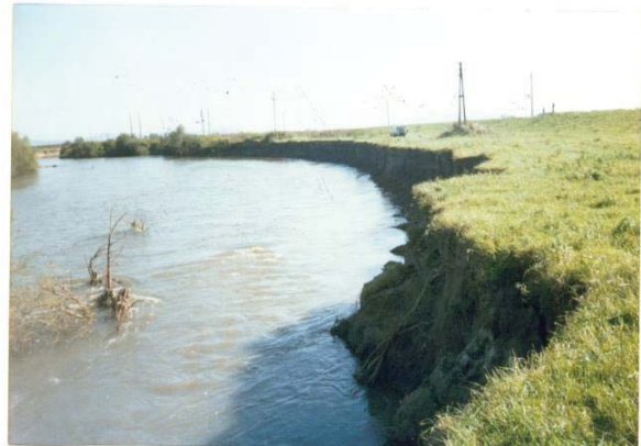
Râul Timiș amonte confluență Ghimbășel
