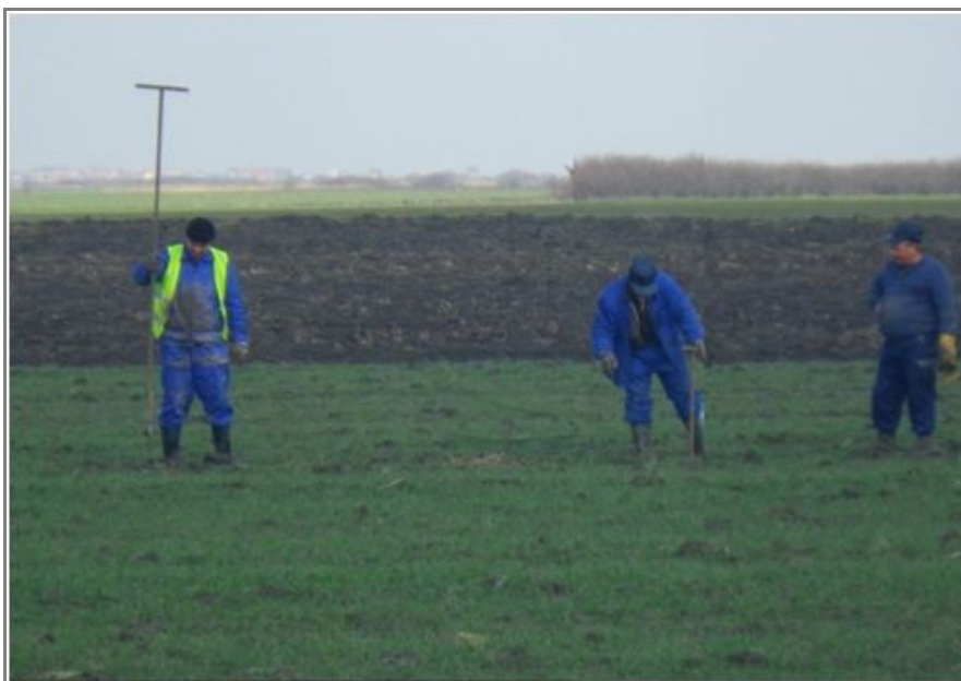
Realizarea manuală a găurilor
