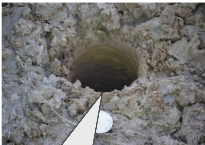
Gaură de detonare controlată
