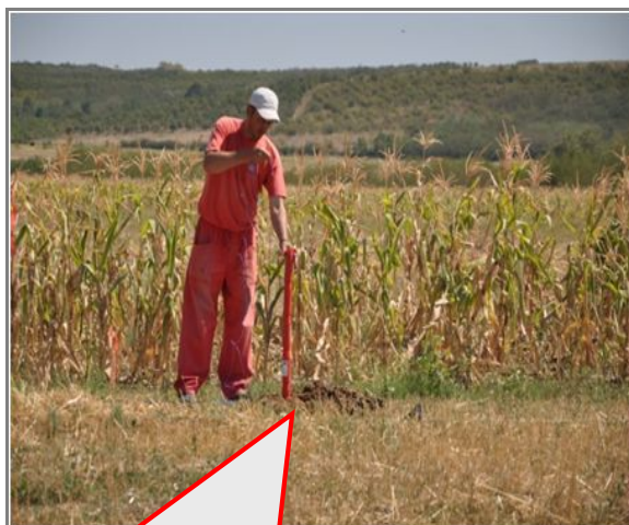
Încărcarea găurii de către un artificier
