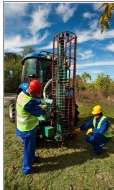
Realizarea mecanică a găurilor
