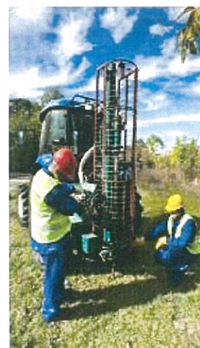
Fig. 8: Realizarea mecanica a găurilor
