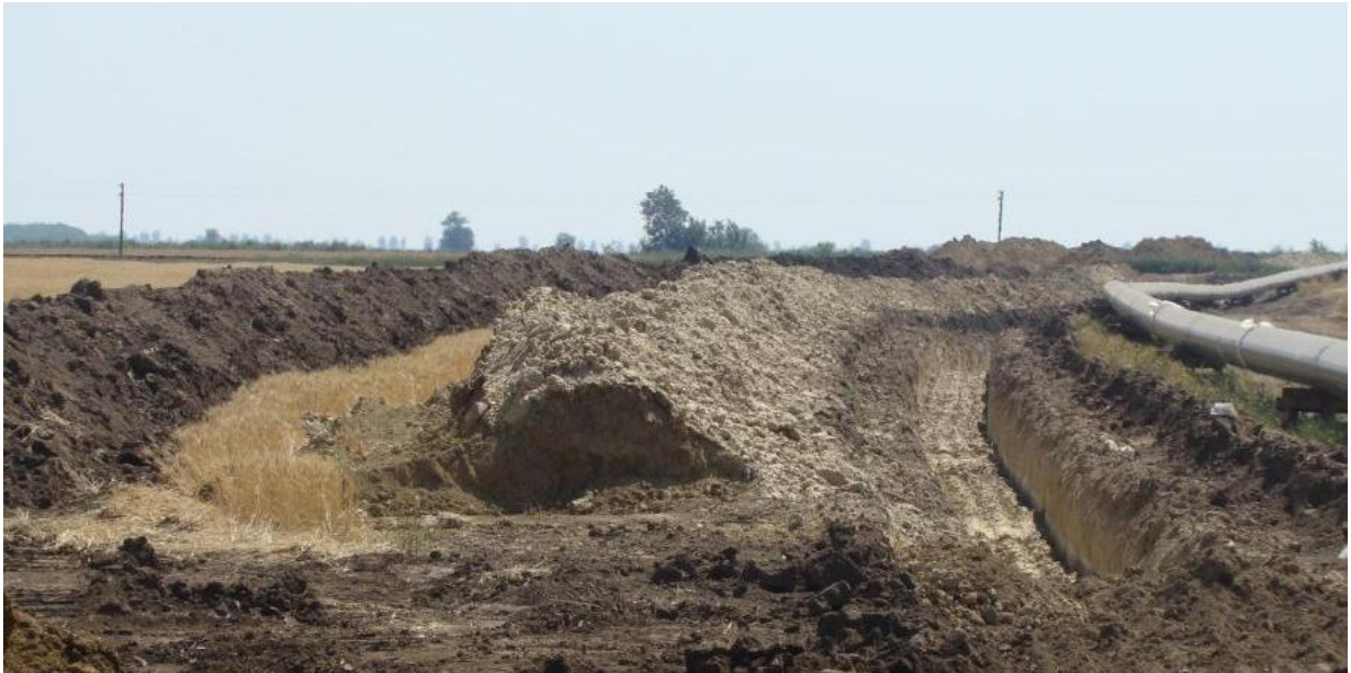
Figura 5 Aspectul unui culoar de lucru pentru amplasarea unei conducte de transport gaze naturale
