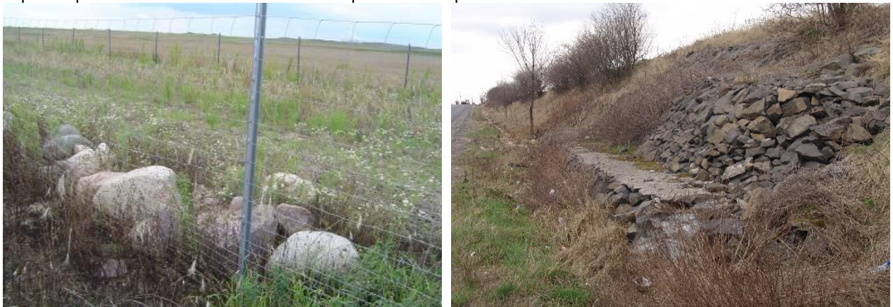
Figura 48 Utilizarea de bolovănișuri ca microhabitate este în măsură a oferi nișe suplimentare ecologice (stânga) și funcționând ca zone de drenaj a apelor de spălare ce contribuie substanțial la stabilizarea pantelor (dreapta)
