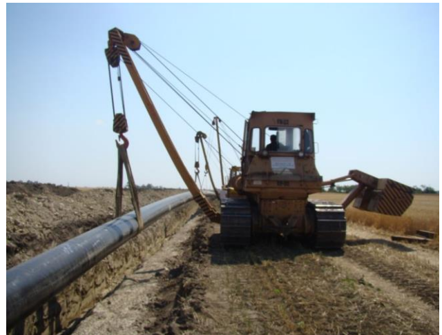
Figura 6 Etapa de lansare a conductei de transport gaze naturale schematic (stânga) și aspect de la nivelul unui șantier (dreapta)
