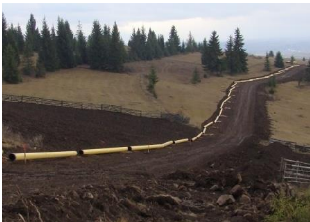
Figura 23 Segmente de țevă înșirate în lungul șanțului (stânga); Verificarea izolației înainte lansării conductei în șanț (dreapta)
