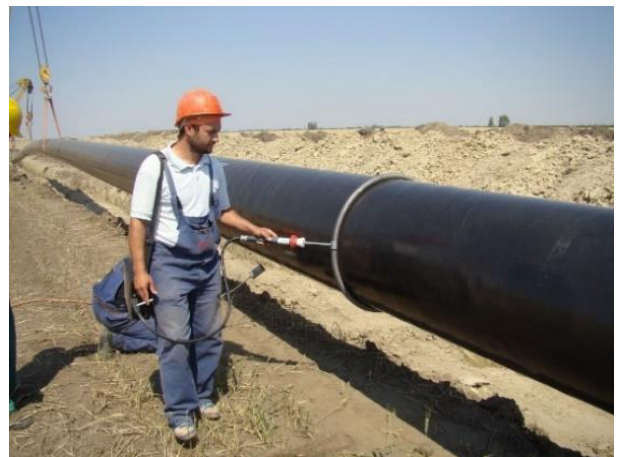
Figura 23 Segmente de țevă înșirate în lungul șanțului (stânga); Verificarea izolației înainte lansării conductei în șanț (dreapta)
