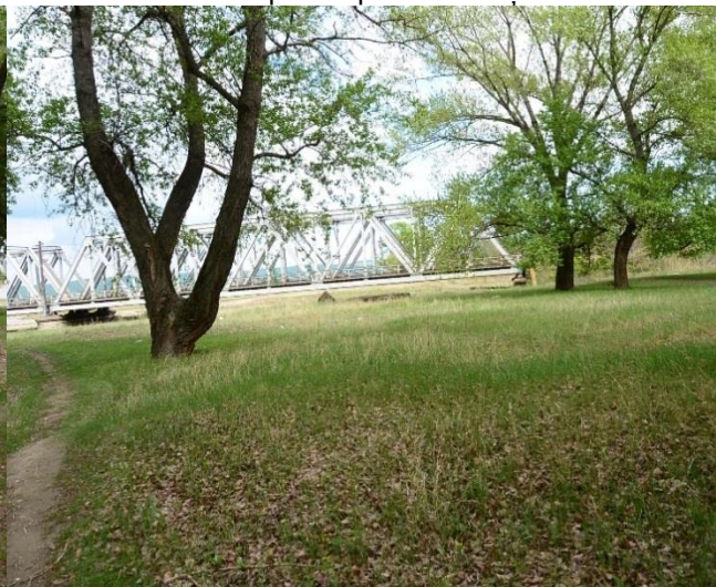
Pod actual de cale ferată peste râul Trotuș
