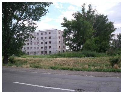
Figura 24. Intersecția km 1+100 cu Calea Galați
