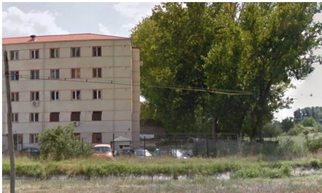
Figura 41. Blocul situat pe strada Galați în vecinătatea amplasamentului proiectului
