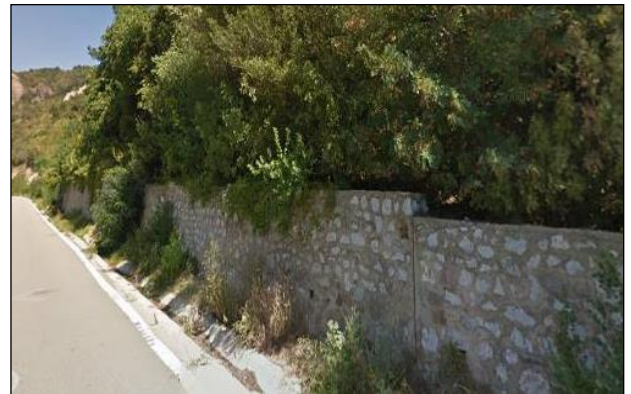
km 63+500 – zid de retenție, cu taluz stabil
