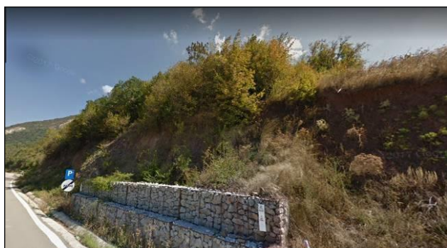
km 61+100 - zid de retenție din gabioane
