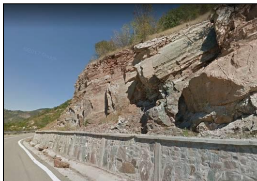
km 57+100—ziduri din zidărie de piatră
