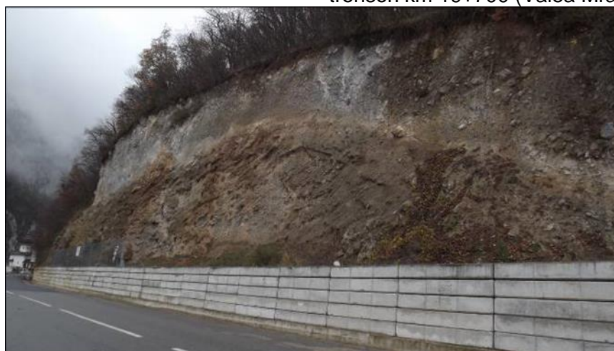
tronson km 19+700 (Valea Mraconiei) – km 22+000
