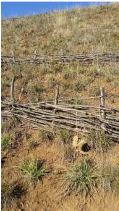
Figură 88 Cleionaje aplicate în lung de pantă în vederea evitării eroziunii și favorizarea refacerii covorului vegetal ierbos: stânga – detaliu; dreapta – vedere de ansamblu de aplicare în lungul unei pante cu risc de eroziune
