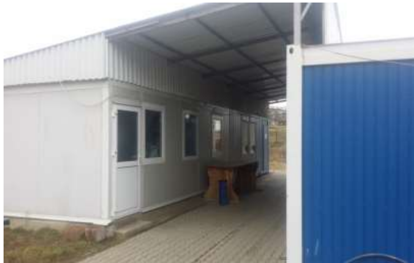
Figură 39 Model de organizare de șantier realizată din containere mobile
