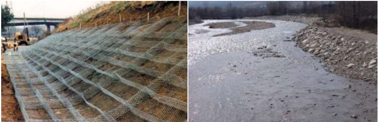
Figură 44 Soluții de stabilizare a malurilor: stânga: modelul unei saltele de gabioane pregătită a primi anrocamentele (Arrigo Gabioni Inc); dreapta: utilizarea de anrocamente pentru protecția unor maluri;
