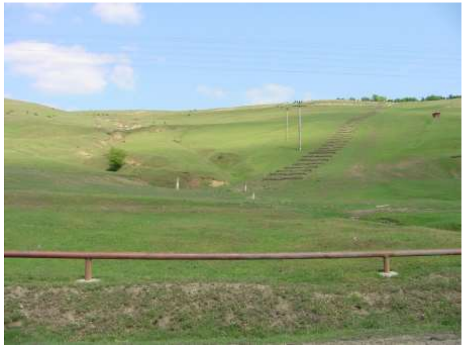
Figură 88 Cleionaje aplicate în lung de pantă în vederea evitării eroziunii și favorizarea refacerii covorului vegetal ierbos: stânga – detaliu; dreapta – vedere de ansamblu de aplicare în lungul unei pante cu risc de eroziune
