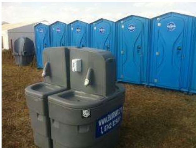
Figură 8 Modele de soluții de asigurarea a condițiilor de igienă pe amplasamente temporare (organizări de șantier/depozite de țeavă, fronturi de lucru, etc.): toalete ecologice, cu bazin etanș, vidanjabil, tratat chimic; lavoare de spălare cu rezervoare etanșe ce asigură apa de spălare ce este apoi re-introdusă în rezervor distinct, etanș, vidanjabil (stânga); cabină de duș modulară cu rezervoare etanșe distincte: rezervor apă pentru spălare, rezervor etanș, vidanjabil pentru apa utilizată (dreapta)
