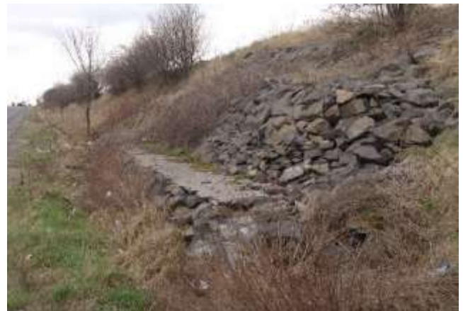
Figură 82 Utilizarea de bolovănișuri ca microhabitate este în măsură a oferi nișe suplimentare ecologice (stânga) și funcționând ca zone de drenaj a apelor de spălare ce contribuie substanțial la stabilizarea pantelor (dreapta)
