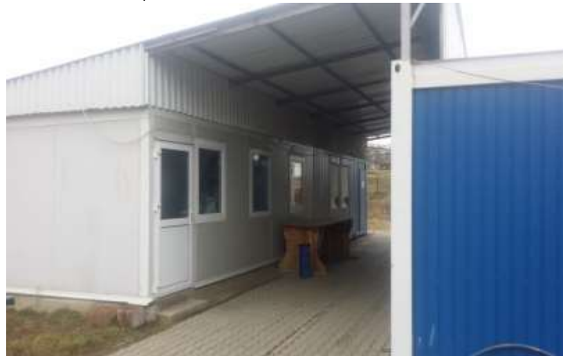
Figură 6 Model de organizare de șantier realizată din containere mobile
