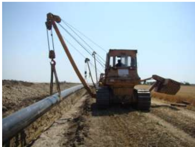
Figură 22 Etapa de lansare a conductei de transport gaze naturale schematic (stânga) și aspect de la nivelul unui șantier (dreapta)
