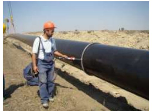
Figură 31 Verificarea izolației înaintea lansării conductei în șanț
