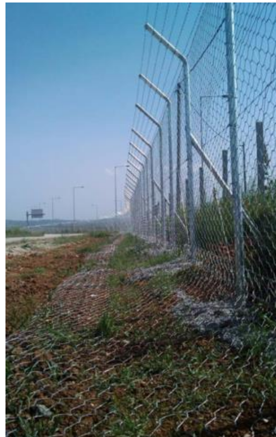
Figura nr. 2-13 Exemple de gard ranforsat utilizat la Autostrada Egnatia, Grecia: A. Schema gardului ranforsat; B. Gardul ranforsat nou instalat în paralel cu gardul vechi; C. Exemplu al soluției utilizate pentru a preveni pătrunderea faunei sălbatice pe sub gardul ranforsat
