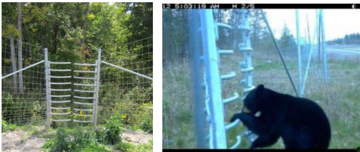
Figura nr. 2-14 Exemple ale unor porți de ieșire pentru fauna sălbatică ajunsă în zona carosabilului autostrăzii
