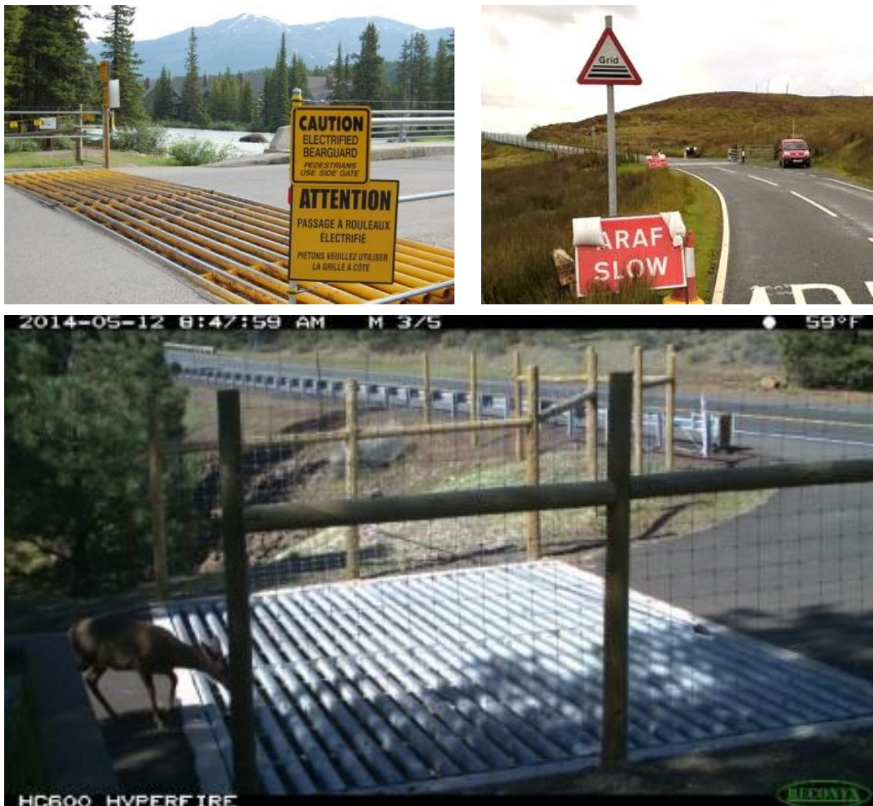
Figura nr. 5-21 A. Exemplu al unui grilaj electrificat pentru fauna sălbatică; B Exemplu al unui panou de avertizare montat pe un drum din Țara Galilor pentru a atenționa șoferii cu privire la prezența unui grilaj; C. Grilaj instalat pentru a evita pătrunderea faunei sălbatică pe carosabilul unui drum din Washington, SUA
