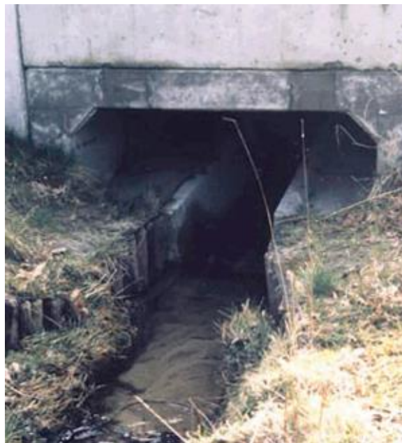
Figura nr. 5-6 Exemple ale unor subtraversări pentru specii de faună de dimensiuni mici, similare celor propuse ca măsură pentru menținerea conectivității (sursa: Iuell, 2003)
