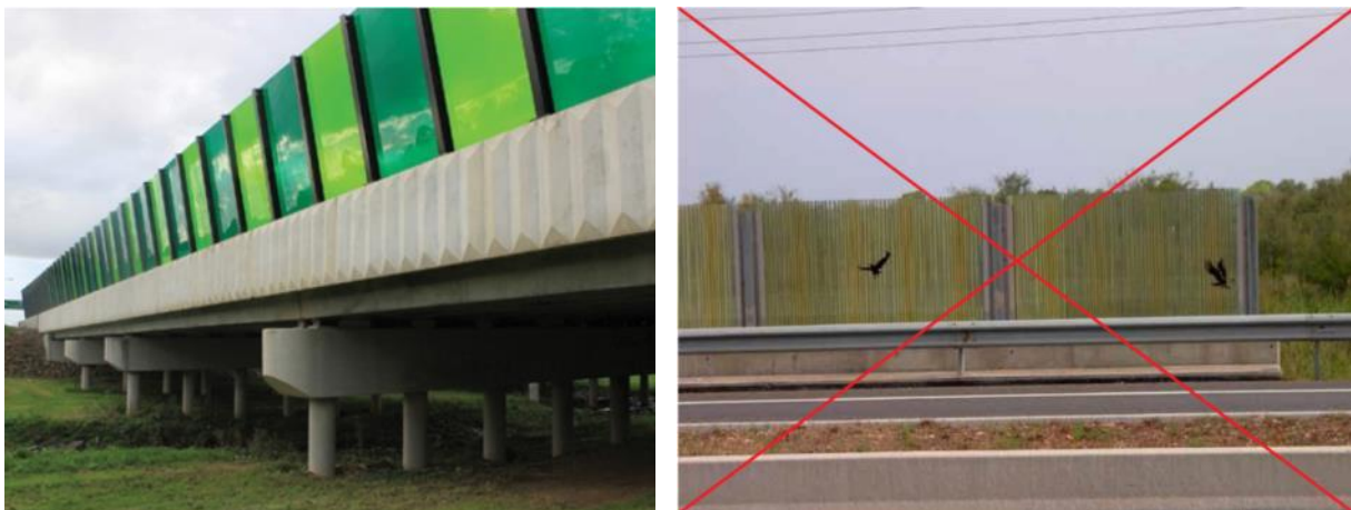
Figura nr. 5-4 Exemple ale unor panouri care pot contribui la protecția anticoliziune
