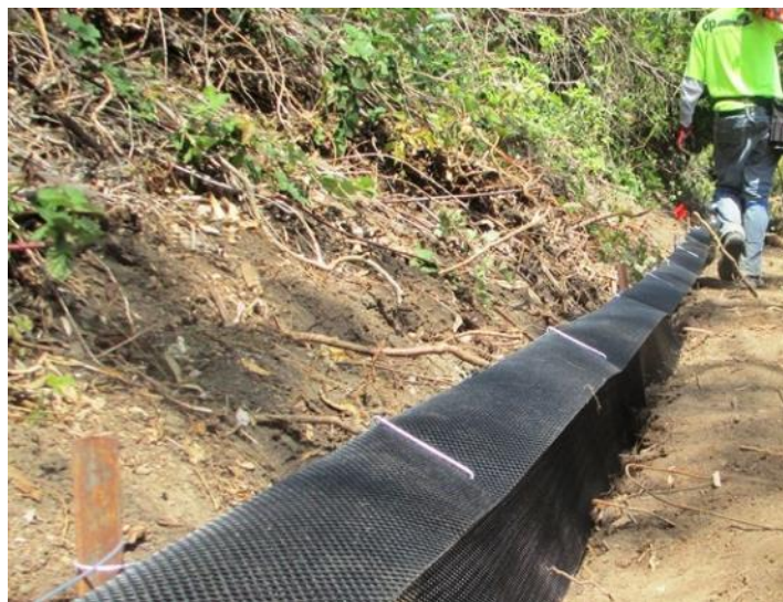
Figura nr. 5-8 Exemplu al unui gard permanent pentru amfibieni și reptile
