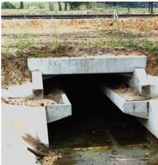
Figura nr. 5-6 Exemple ale unor subtraversări pentru specii de faună de dimensiuni mici, similare celor propuse ca măsură pentru menținerea conectivității (sursa: Iuell, 2003)
