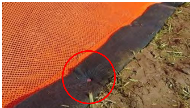
Figura nr. 5-9 Securizarea părții inferioare a gardului în sol
