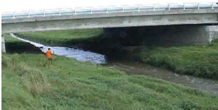
Figura nr. 5-5 Exemplu al unui pod care menține malurile naturale ale râului pe care îl traversează (Iuell, 2003)
