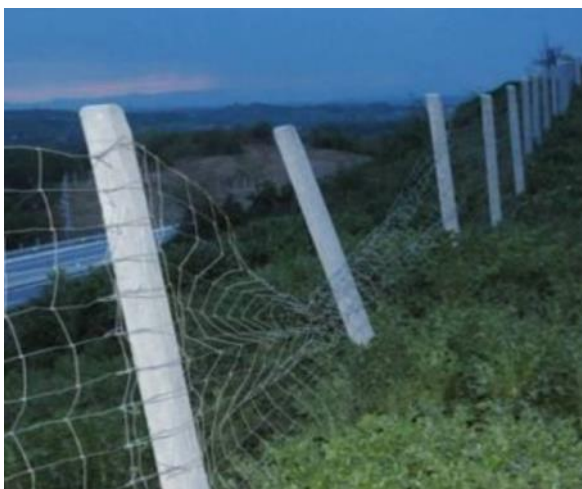
Figura nr. 5-18 Exemplu al unui gard rupt în zona autostrăzii și consecințelor modului de proiectare al acestuia
