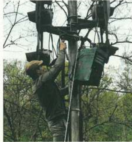
Figura nr. 5-43 Camera video cu înregistrare continuă și montarea acesteia
