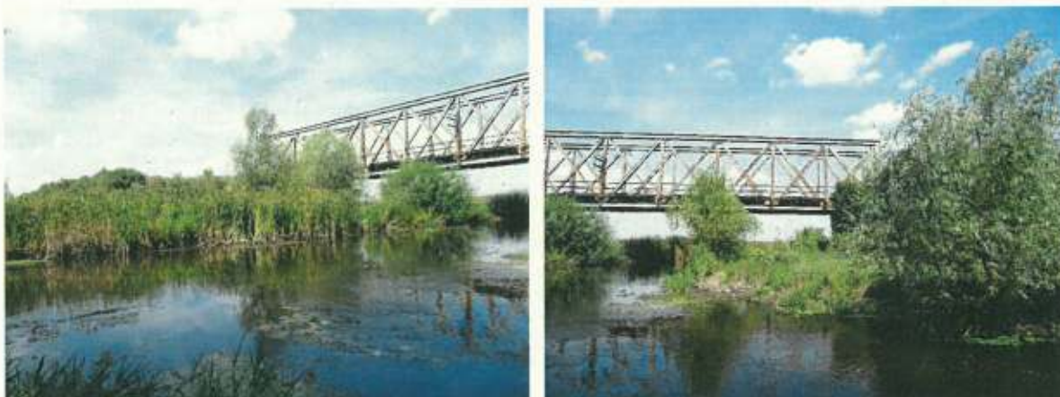
Figura nr. 2-16 Podul existent peste râul Neajlov (partea stângă - malul dinspre Grădiștea; partea dreaptă - malul dinspre Comana)
