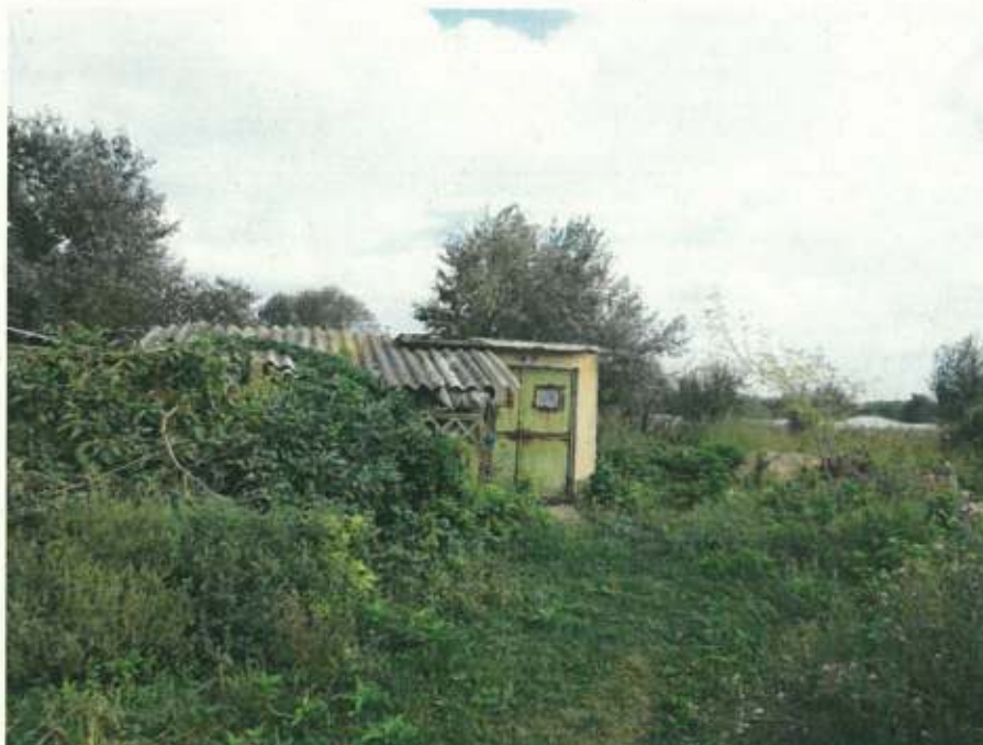
Figura nr. 2-19 Aspectul fostului depozit de carburanți din actuala stație Grădiștea
