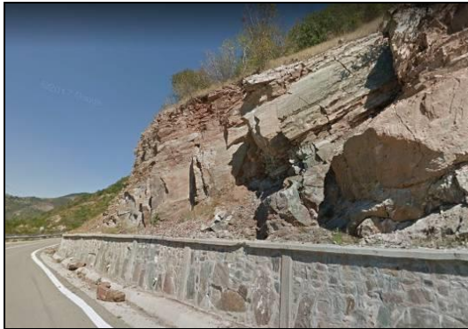
km 57+100–ziduri din zidărie de piatră
