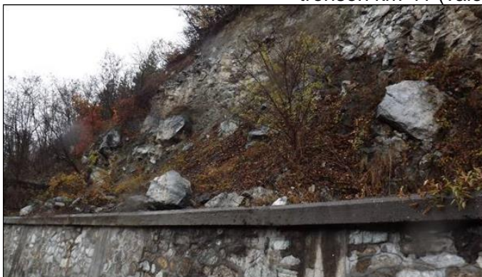
tronson km 41 (valea bazinu mare) – km 44+300
