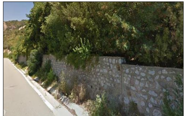
km 63+500 – zid de retenție, cu taluz stabil
