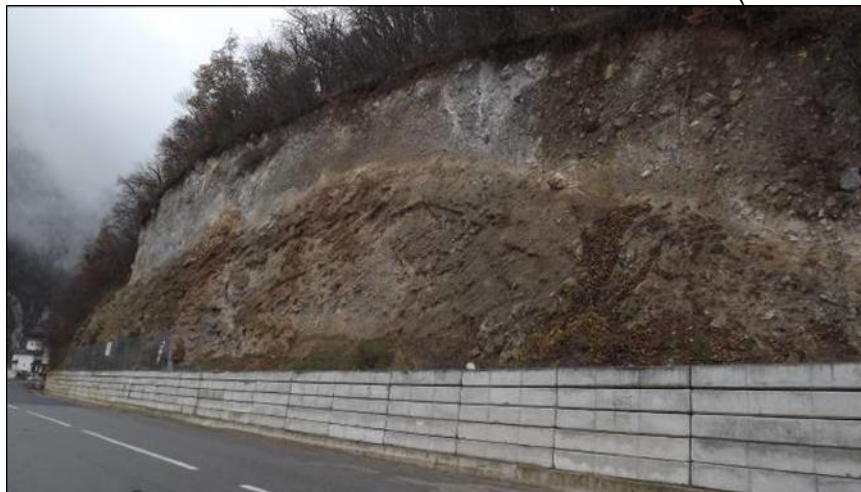
tronson km 19+700 (Valea Mraconiei) – km 22+000
