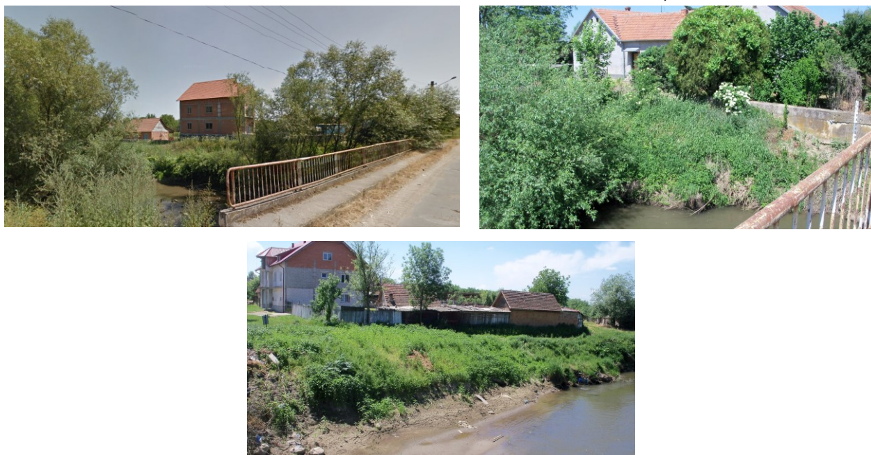
Figura 9. Situația existentă râul Barzava, localitatea Berzovia
