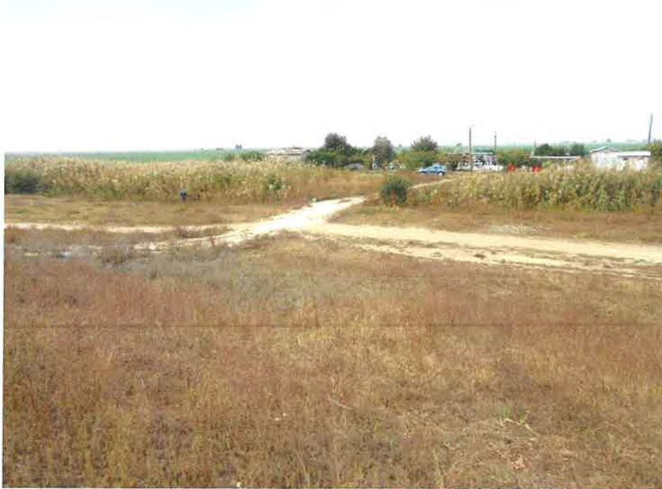
Imagine 19. Vedere de pe digul de apărare împotriva inundațiilor spre C2
