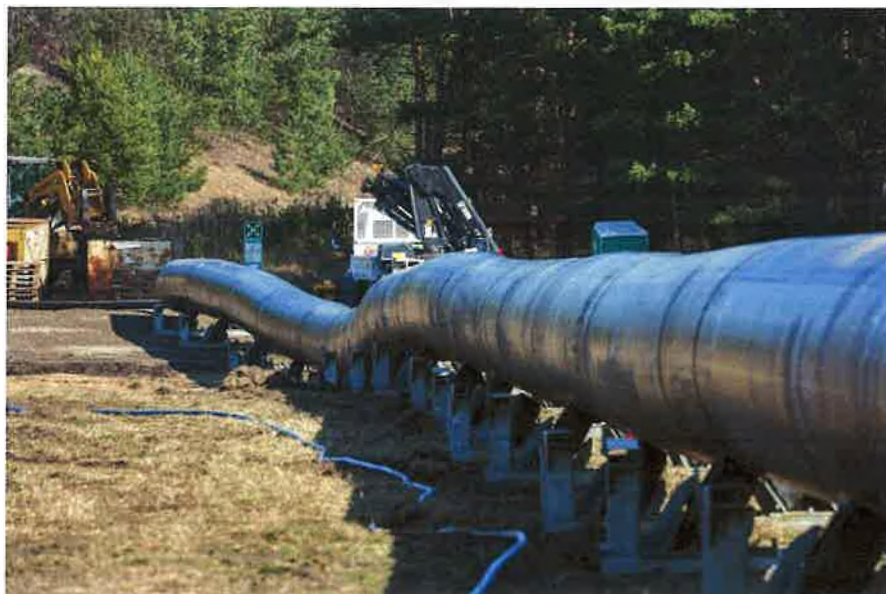
Imagine 8. Conducta produs montată pe role
