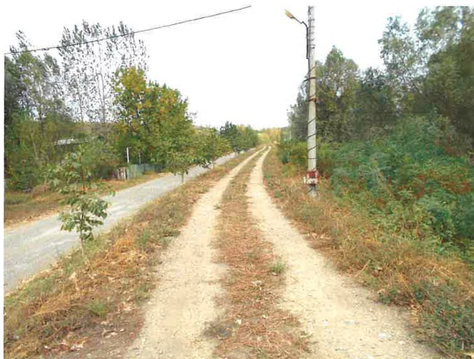
Imagine 24. Dig de apărare împotriva inundațiilor pe malul stâng al brațului Borcea, vedere spre aval – Pensiune “La Popescu”
