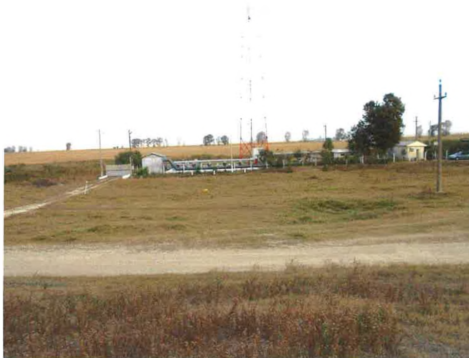
Imagine 21. Vedere de pe digul de apărare împotriva inundațiilor de pe malul drept al brațului Borcea spre punctul de lucru C3
