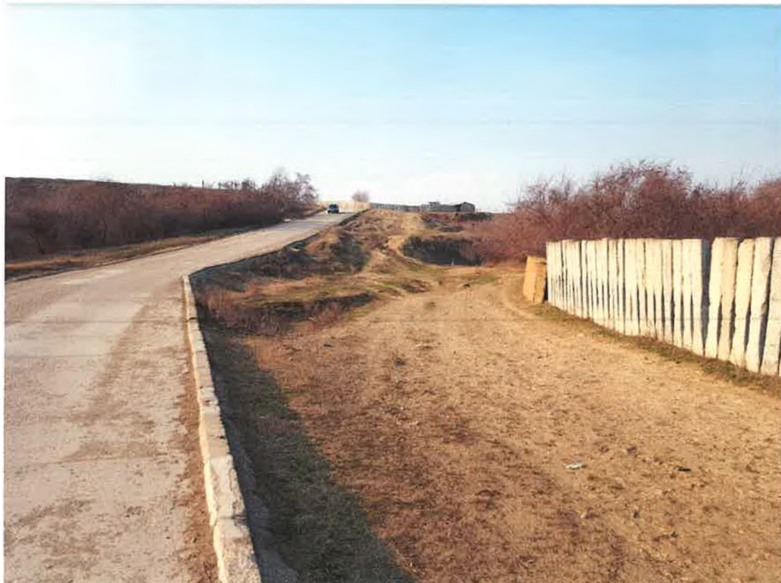
Imagine 27. Vedere de ansamblu zonă adiacentă lucrărilor U.A.T. Fetești
