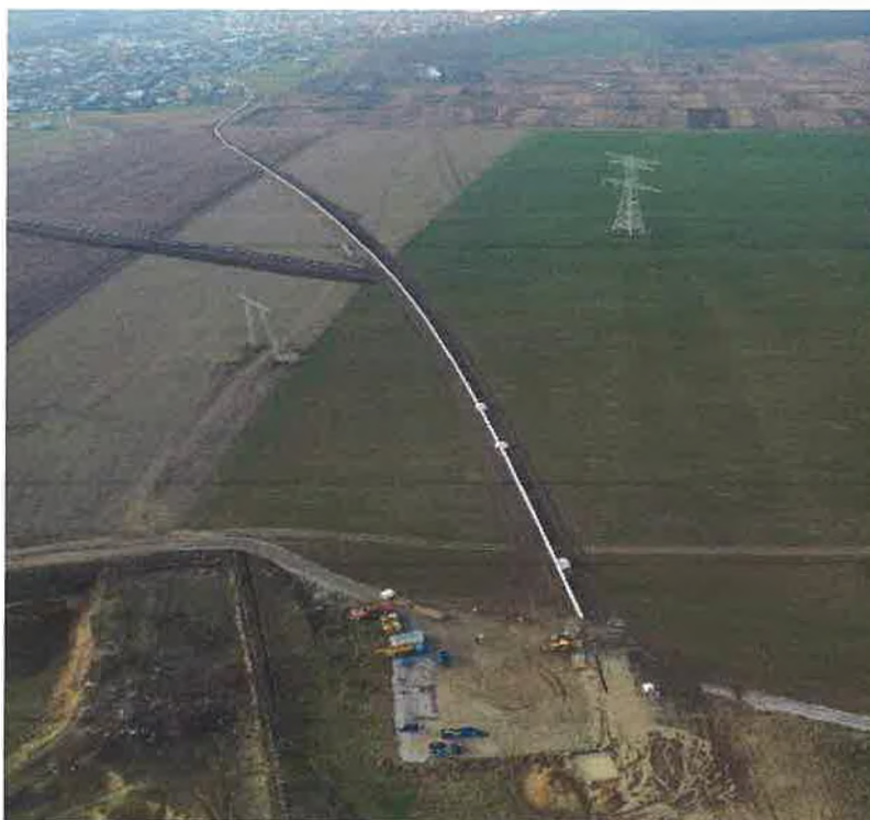
Imagine 10. Poziționare conductă înainte de tragere
