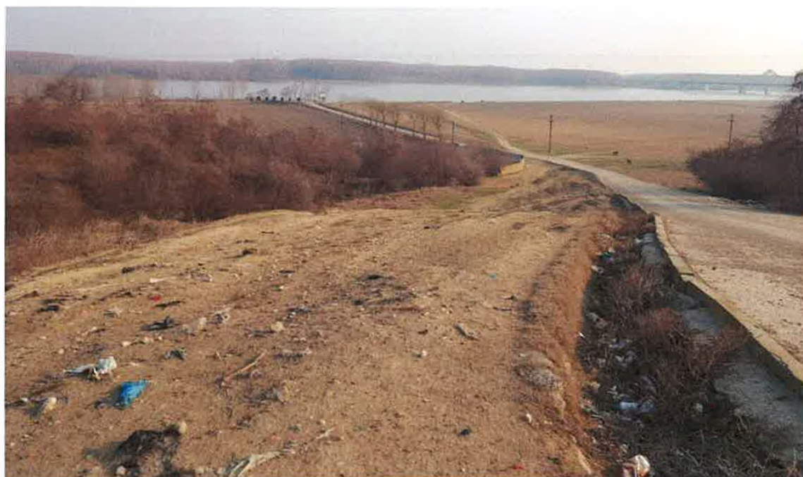
Imagine 28. Vedere de ansamblu zonă adiacentă lucrărilor spre brațul Borcea
