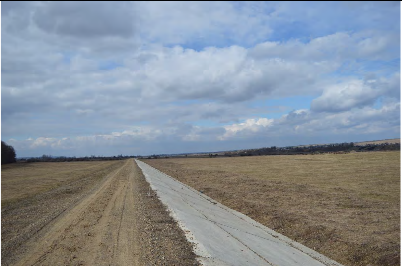
Baraj mal drept – zona amonte
