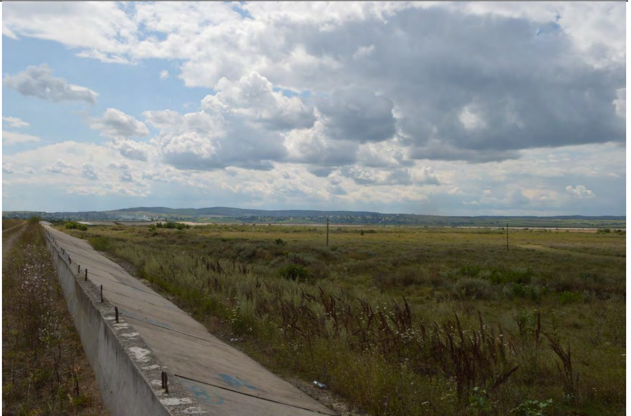
Baraj frontal mal stâng
