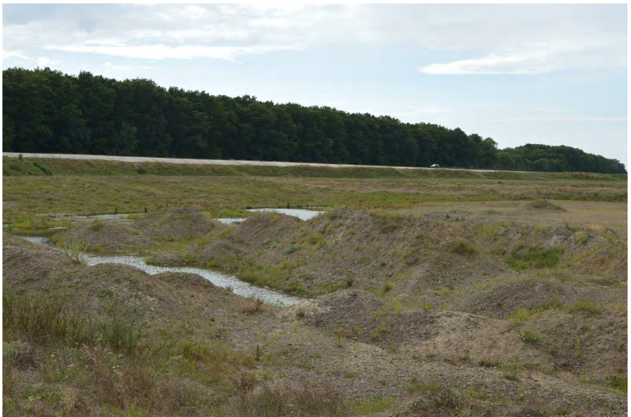
Baraj mal drept – zona amonte
