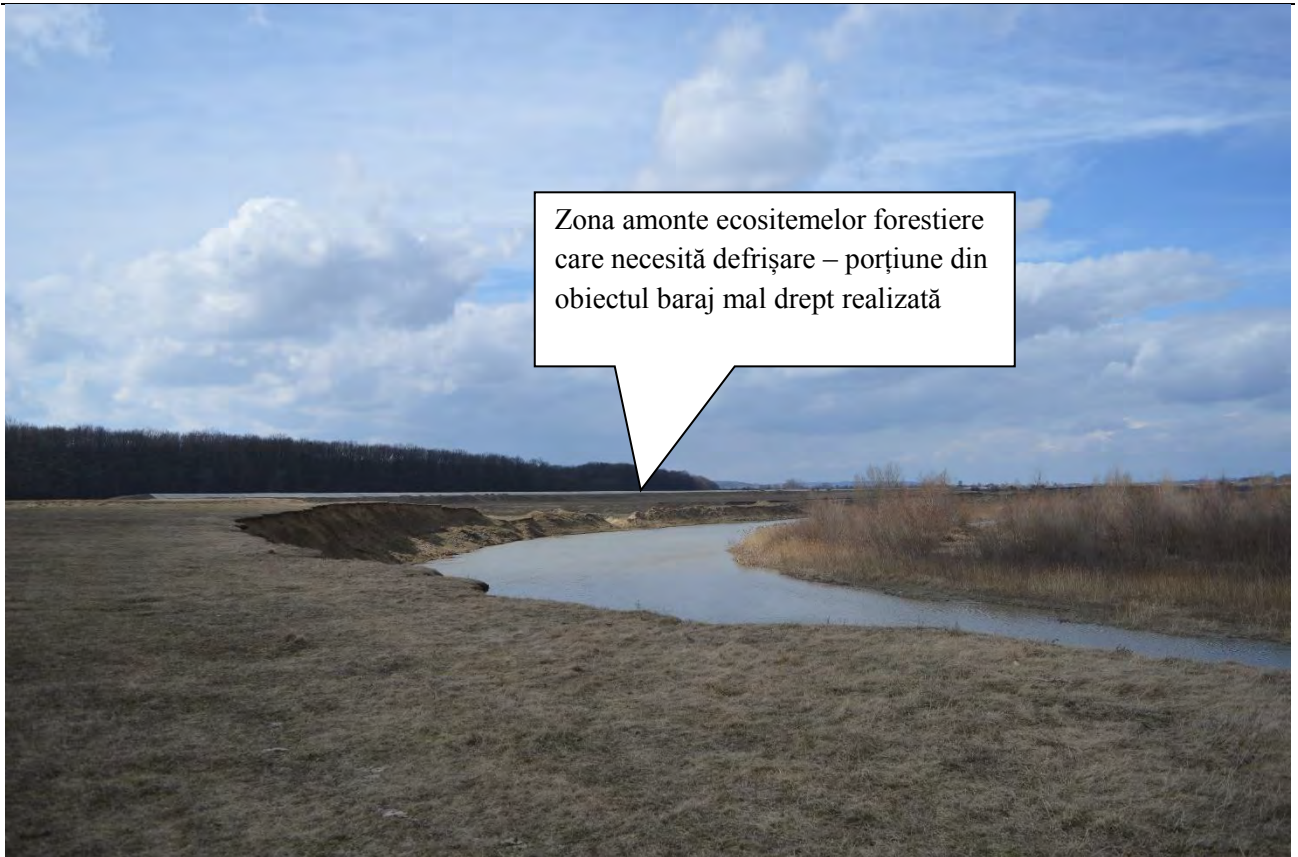
Baraj mal drept – zona amonte
