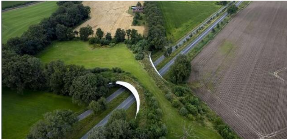
Figura nr. 7-5 Exemplu de ecoduct pentru care este realizată o legătură între vegetația de pe ecoduct și vegetația din marginile parcelelor agricole (sursa: https://c8.alamy.com/zooms/9/0c8a6d6aa4f74c8a84c3a13aa62a4a3b/2gf2xk6.jpg )
