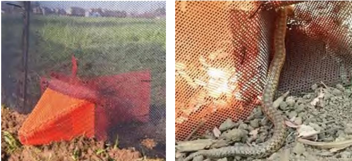
Figura nr. 7-14 Exemplu al unor structuri unidirecționale care permit doar întoarcerea indivizilor din zona autostrăzii
