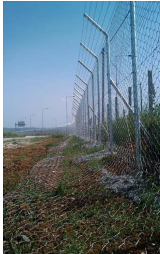
Figura nr. 7-10 A. Schema gardului ranforsat utilizat la Egnatia; B. Gardul ranforsat nou instalat în paralel cu gardul vechi; C. Exemplu al soluției utilizate pentru a preveni pătrunderea faunei sălbatice pe sub gardul ranforsat (sursa: Voumovoulaki, 2017)
