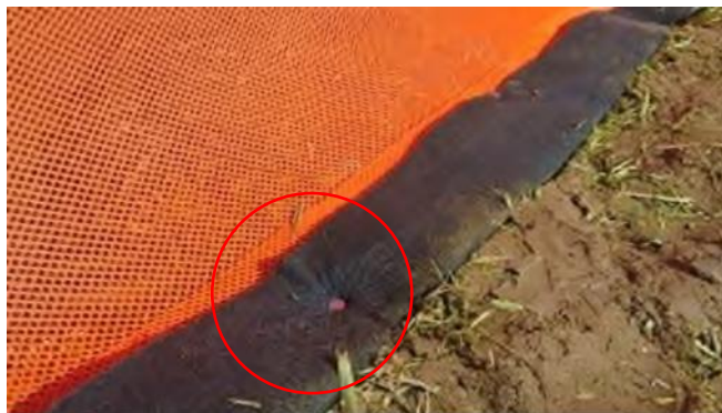
Figura nr. 7-13 Securizarea părții inferioare a gardului în sol (Sursa: ERTEC Environmental Systems)
