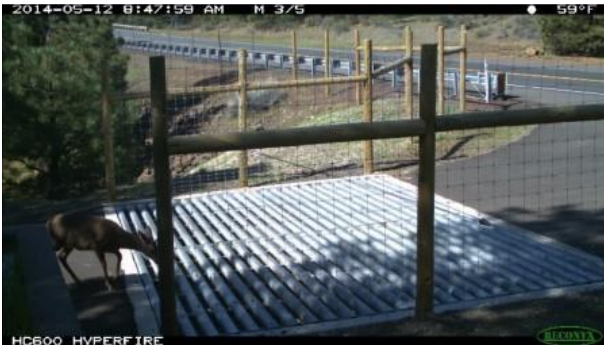
Figura nr. 7-15 A. Exemplu al unui grilaj electrificat pentru fauna sălbatică; B Exemplu al unui panou de avertizare montat pe un drum din Țara Galilor pentru a atenționa șoferii cu privire la prezența unui grilaj; C. Grilaj instalat pentru a evita pătrunderea faunei sălbatice pe carosabilul unui drum din Washington, SUA
