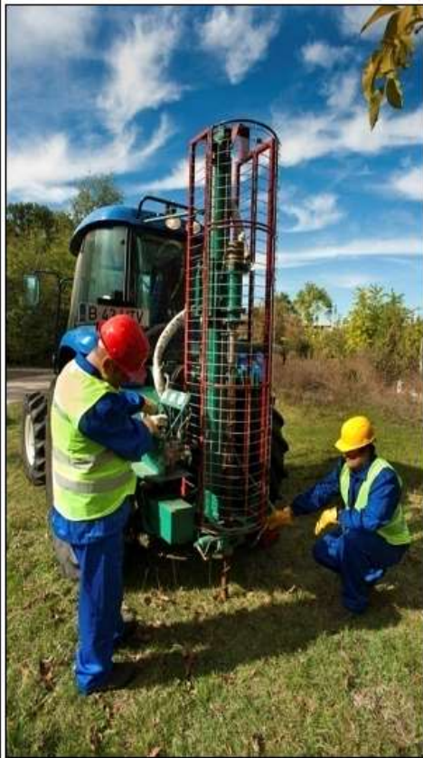
Fig.7 Realizare găurilor cu utilaj mecanic
