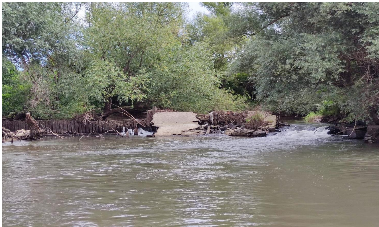
Figura 3-5. Aspect din zona de intravilan a localității Berzovia unde se poate observa un prag de cădere degradat care se propune spre reabilitare.
