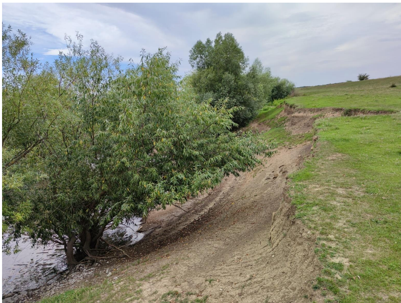
Figura 2-2. Zonă în care se pot observa punctele de eroziune și de depunere de pe râul Bârzava, uvraj polder
