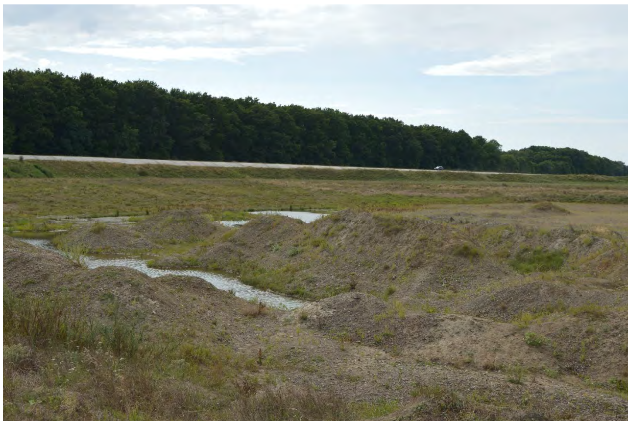
Baraj mal drept – zona amonte
