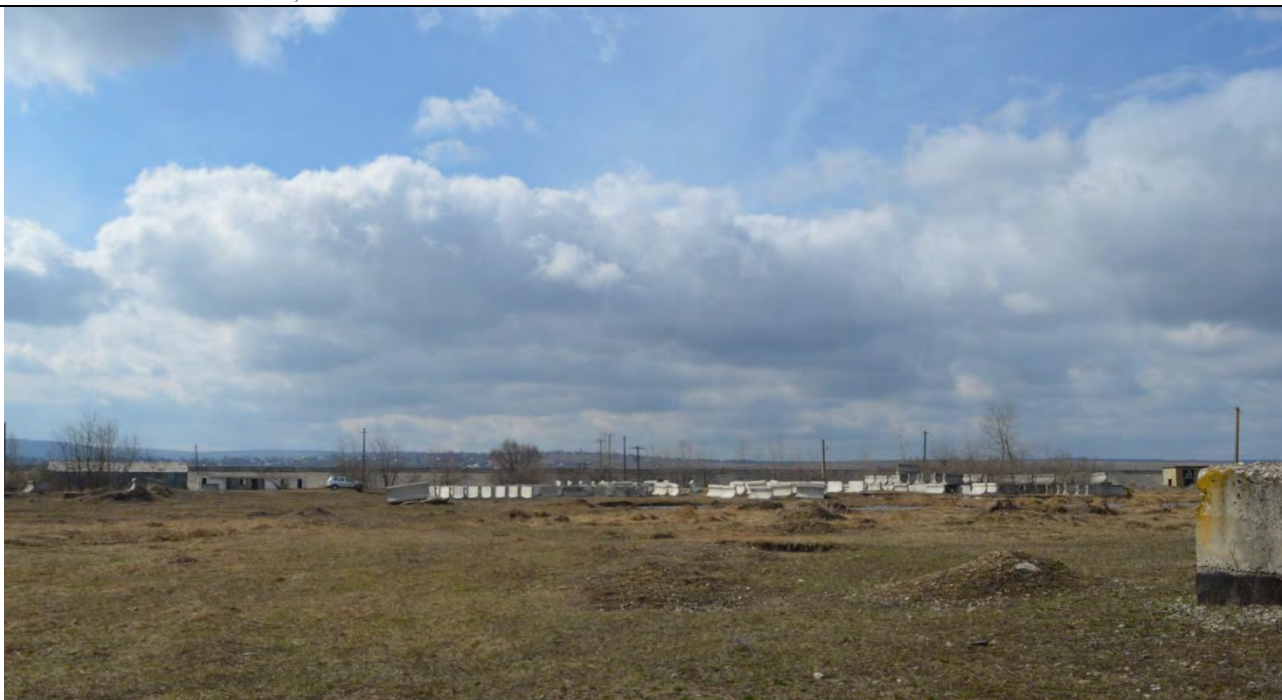
Organizarea de șantier amenajată în anii '80 – '90 – aceasta va fi demolată iar deșeurile vor fi transportate și gestionate conform legii
