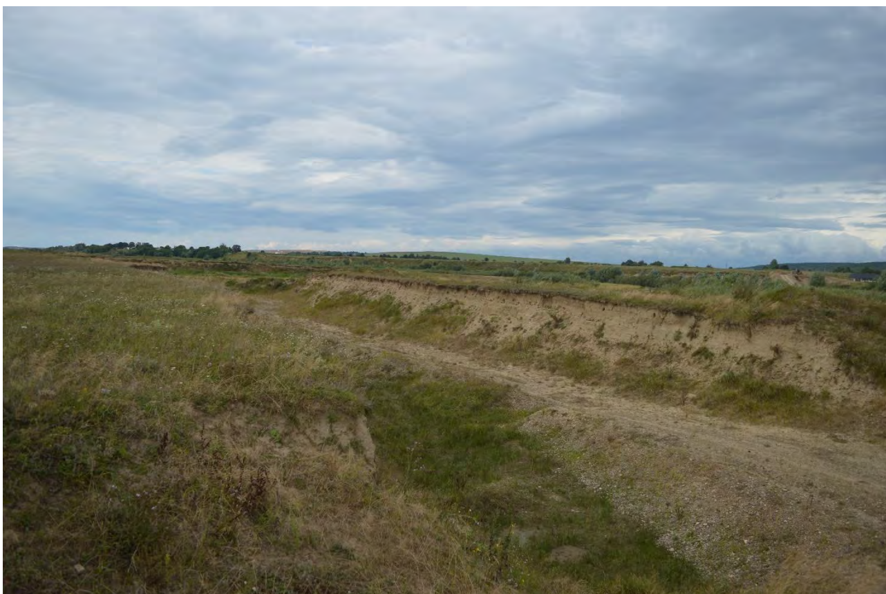
Declivități la nivelul cuvetei acumulării rezultate din exploatarea de balast folosit la umluturi în corpul digurilor
