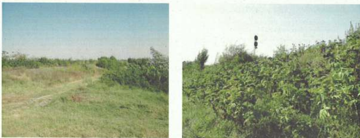
Figura nr. 3-21 Imagini din zona de dig în apropiere de râul Neajlov
