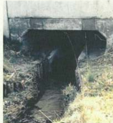
Figura nr. 5-14 Exemple ale unor subtraversări pentru specii de faună de dimensiuni mici și medii, similare celor propuse ca măsură pentru menținerea conectivității
