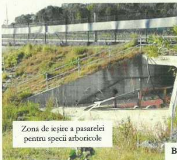
Figura nr. 5-10 A. Subtraversare adaptată pentru particularitățile de deplasare a mai multor specii; B. Zona de ieșire a unei subtraversări adaptată pentru mai multe specii; C: Exemplu de utilizare al unei pasarele de către un individ al speciei Lutra lutra
