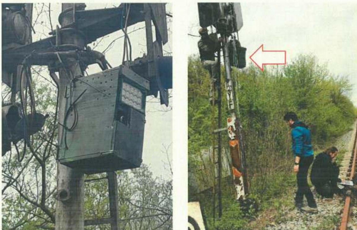
Figura nr. 7-6 Camera video cu înregistrare continuă și montarea acesteia
