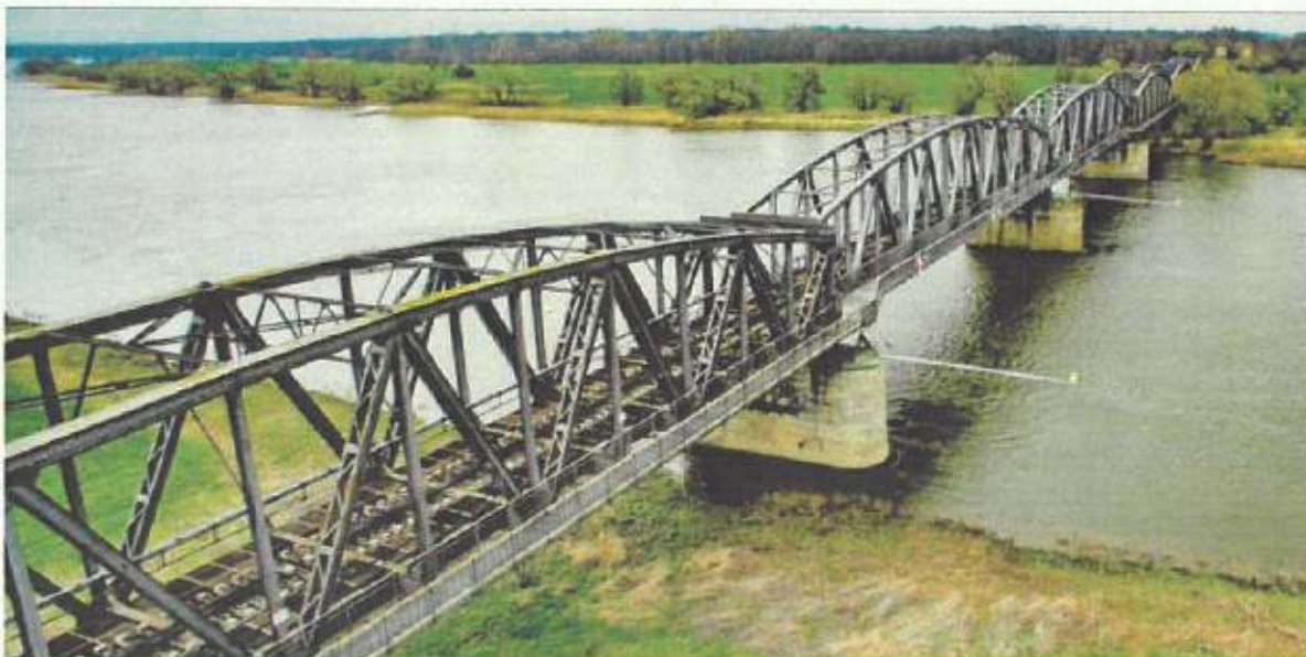
Figura nr. 5-3 Exemplu al unui pod care menține malurile naturale ale râului pe care îl traversează ( https://www.mz-web.de/salzlandkreis/heimat-aus-stahl-neues-leben-fuer-die-eisenbahnbruecke-von-barby--32311602 )
