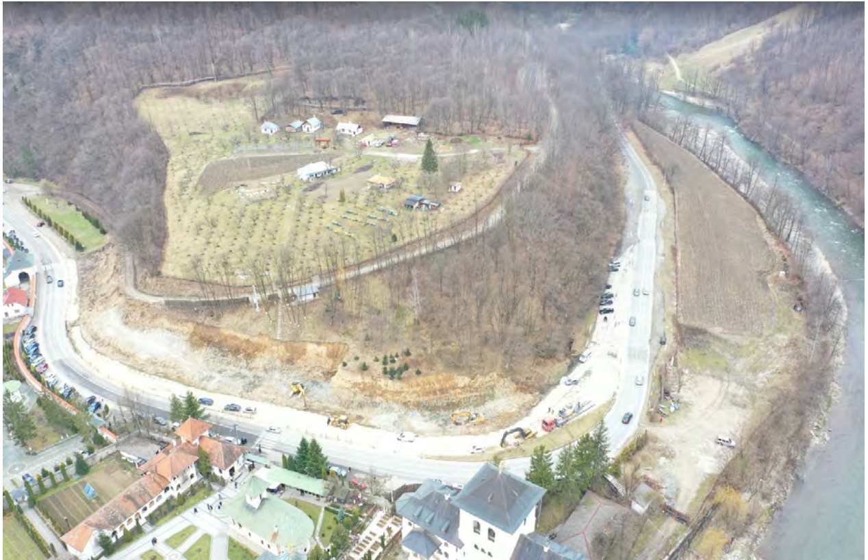
Fig. 5. Fotografie privind necesitatea unei parări prin reamenajare sector km 106+220 - km 106+965 din zona Mănăstirii Lainici
