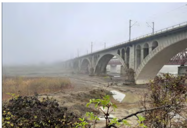
Figura - Pilele podului peste râul Buzău ce vor fi reparate în cadrul proiectului
