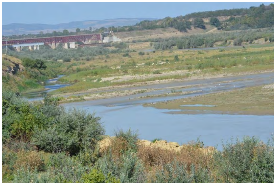
Figura - Vedere ansamblu aval 50m pod cf peste râul Buzău
