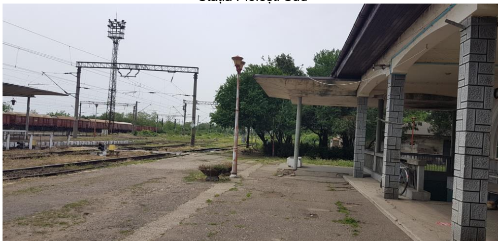
Stația Ploiești Est
