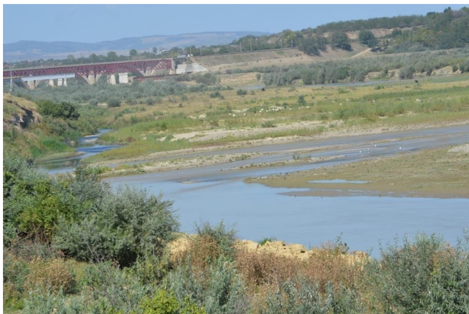
Figura 71 - Vedere ansamblu 50m aval de podul de cale ferată peste râul Buzău
