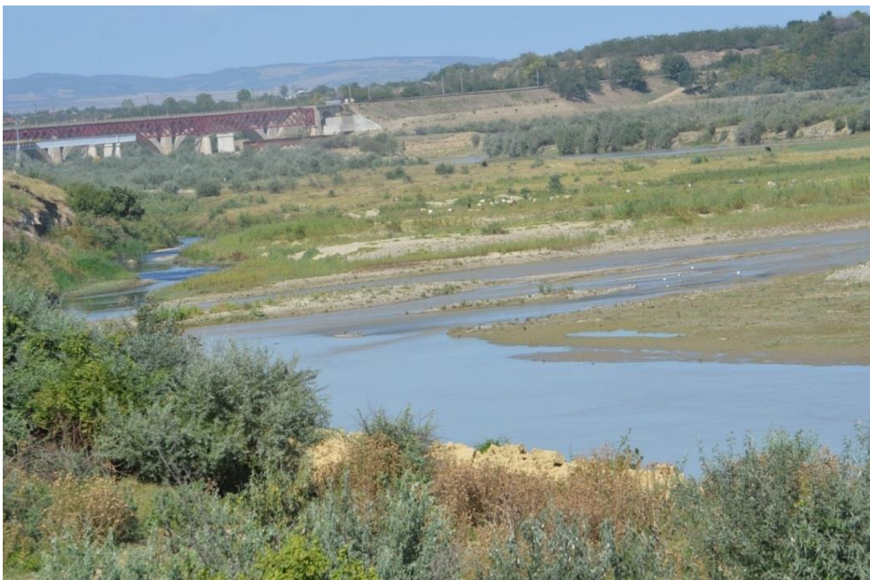
Figura 61. Vedere ansamblu aval 50m pod cf peste râul Buzău
