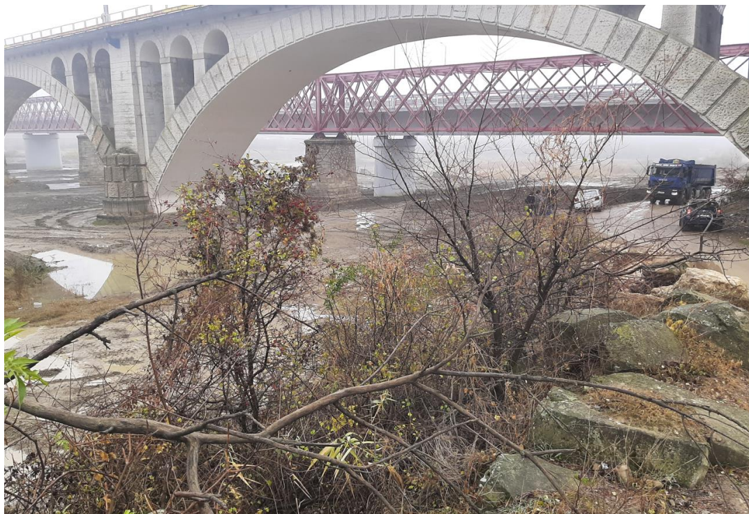
Figura 34. Imagine cu podurile ce susțin infrastructuri de transport în interiorul ariilor Natura 2000 suprapuse ROSAC0103 și ROSPA0160 Lunca Buzăul (în plan apropiat podul de cale ferată din bolti gemene din beton armat ce face obiectul reabilitării în cadrul proiectului)
