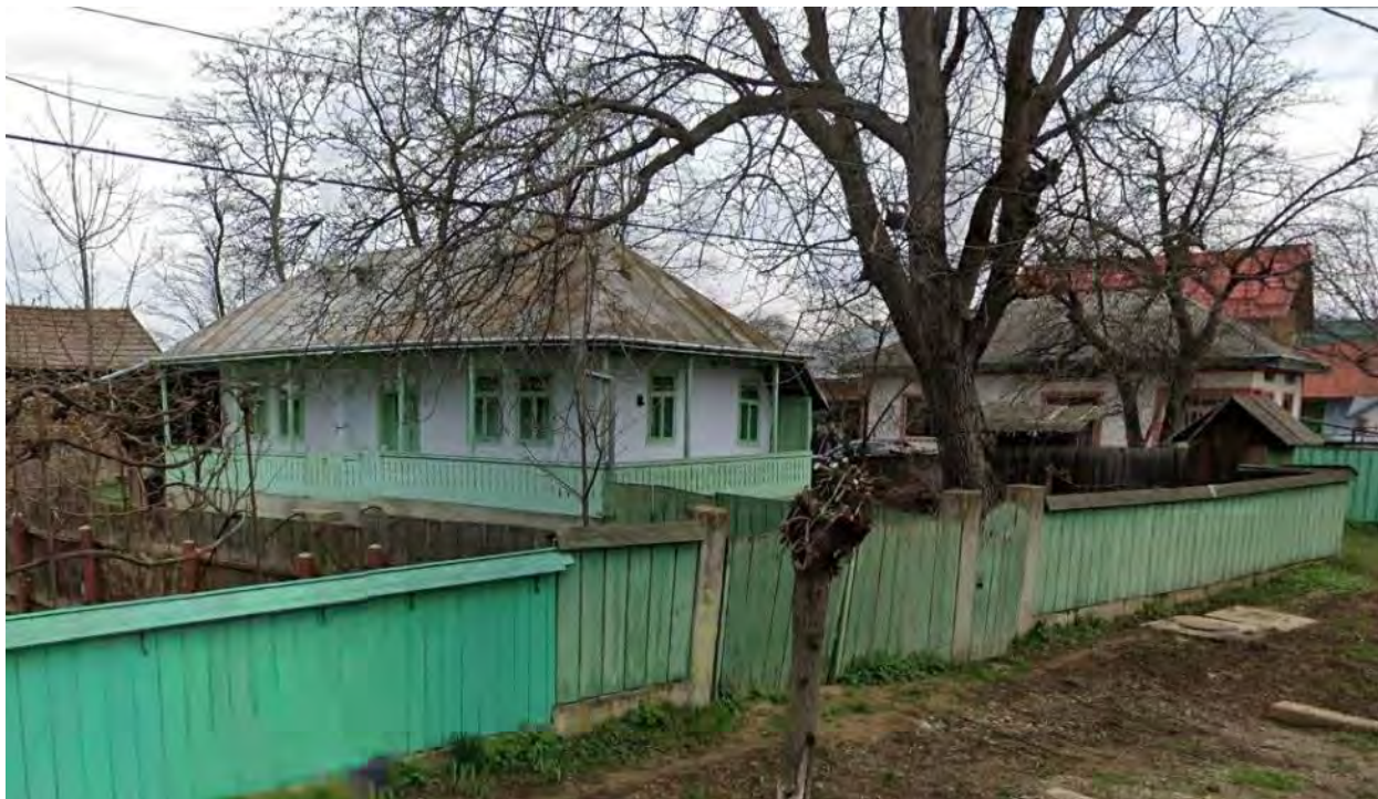
Figura nr. 5-99 Casă cu prispă, cu acoperiș din șindrilă și gard din lemn cu acoperiș în localitatea Verești, județul Suceava (sursă Google Earth)
