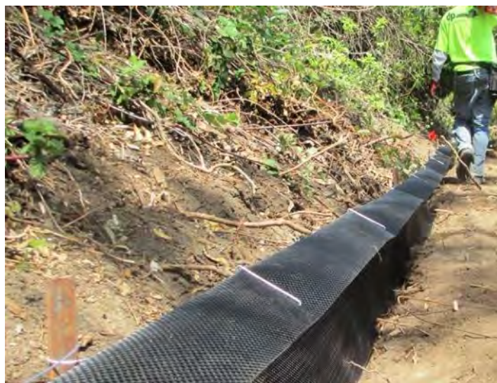
Figura nr. 5-5 Exemplu al unui gard permanent pentru amfibieni și reptile
