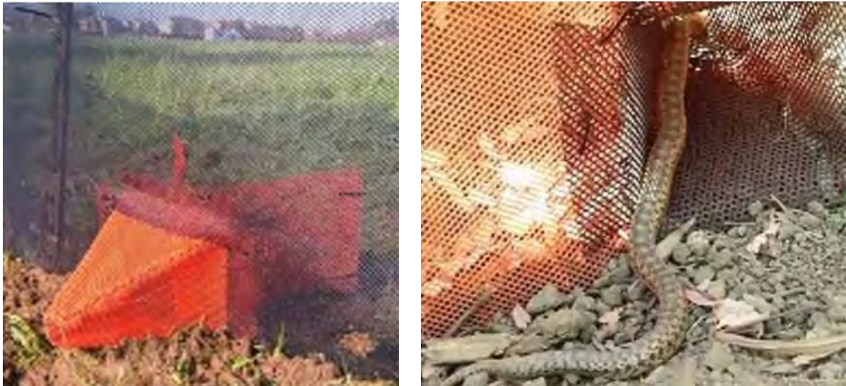
Figura nr. 5-7 Exemplu al unor structuri unidirecționale care permit doar întoarcerea indivizilor din zona autostrăzii
