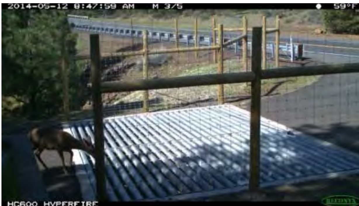
Figura nr. 5-8 A. Exemplu al unui grilaj electrificat pentru fauna sălbatică; B Exemplu al unui panou de avertizare montat pe un drum din Țara Galilor pentru a atenționa șoferii cu privire la prezența unui grilaj; C. Grilaj instalat pentru a evita pătrunderea faunei sălbatică pe carosabilul unui drum din Washington, SUA
