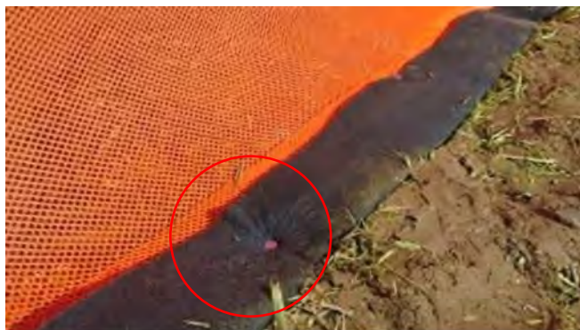
Figura nr. 5-6 Securizarea părții inferioare a gardului în sol
