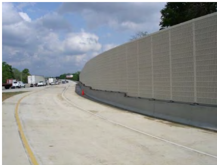
Figura nr. 5-10 Exemplu de panouri fonoabsorbante recomandate pentru autostrada Pașcani - Suceava
