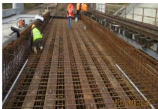
Figura 3. Exemple de tablriere cu grinzi metalice înglobate
