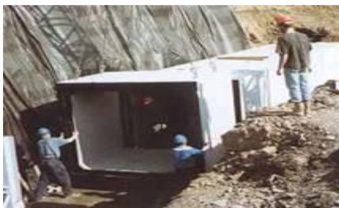
Figura 6. Exemplu de podetș din elemente prefabricate, în faza de execuție
