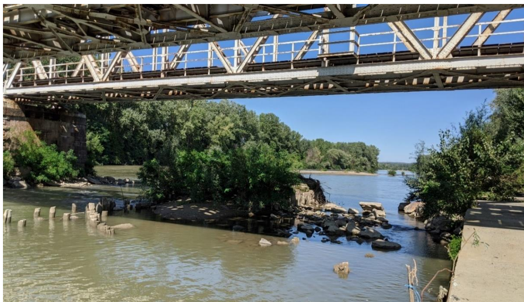
Foto 82. Aspectul râului Jiu la km 291+000
