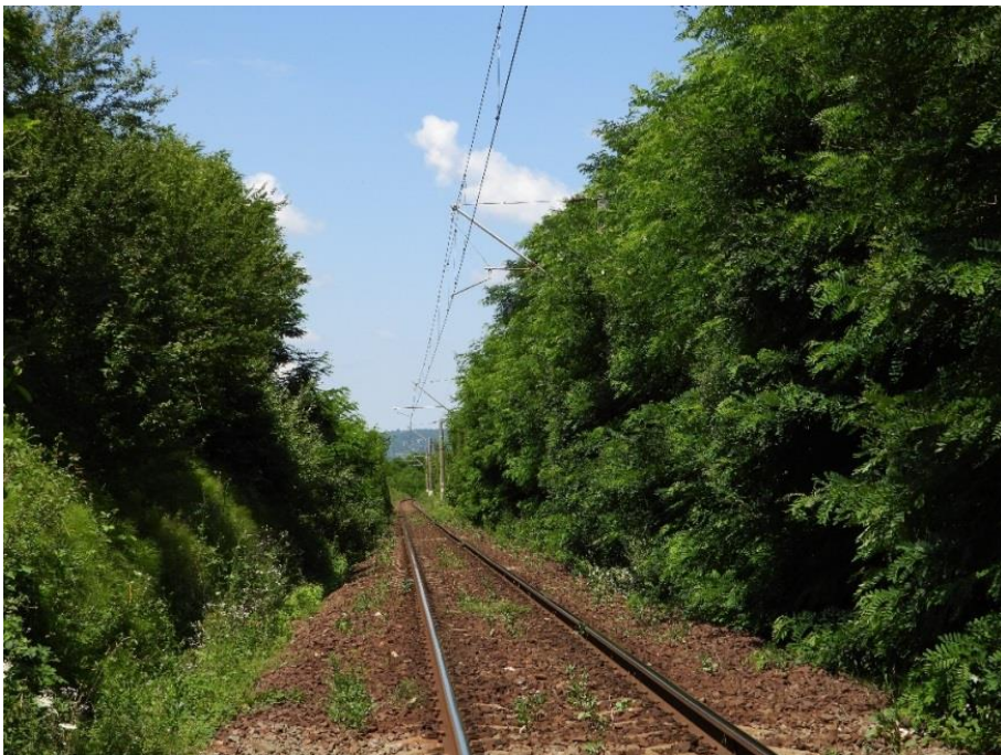
Foto 27. Aspectul amplasamentului stației 19
