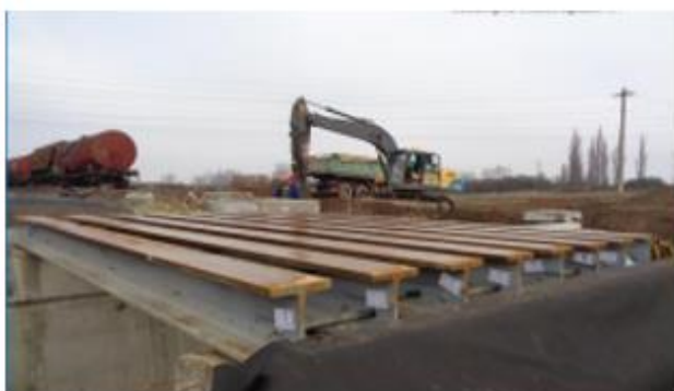
Figura 3. Exemple de tablriere cu grinzi metalice înglobate
