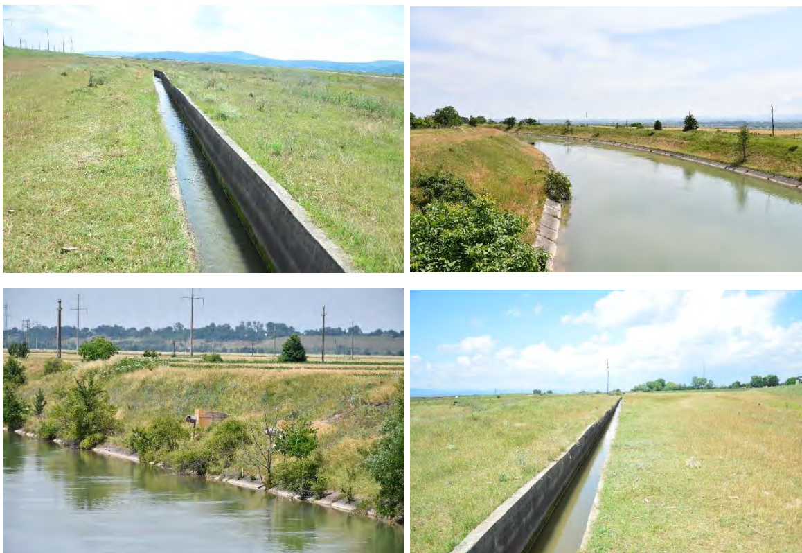
Figura nr. 3-7 Corpul de apă Canalul Piatra Neamț – Buhuși în zona de intersecție cu proiectul
