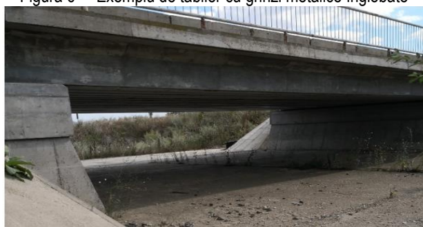
Figura 7 – Exemplu grinzi metalice înglobate în beton
