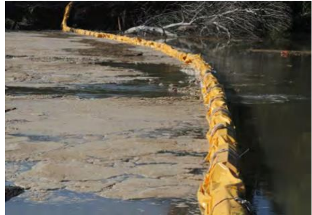
Figura nr. 7-1 Exemplu de barieră plutitoare pentru controlul sedimentelor în apă (sursa: https://www.epd.gov.hk )
