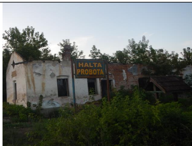
Clădire de călători din Punctul de oprire Probota
