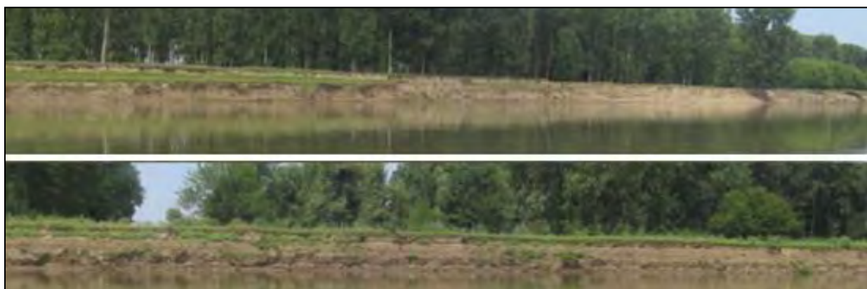
Figura 4.3-26 Maluri verticale de argila situate intre km 565-566
