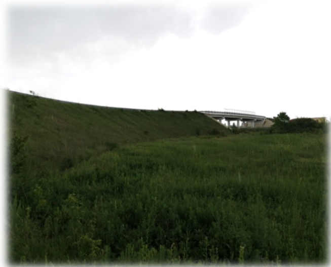
Figura nr. 3: Imagine de ansamblu, zona de inceput a traseului Autostrazii Ploiesti-Buzau
