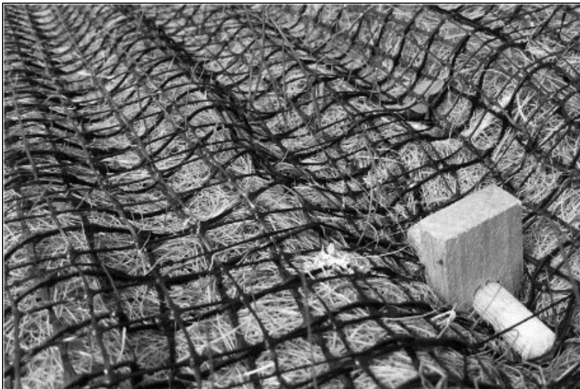
Figura 2.3-12 Protectie eroziune mal cu geotextil
