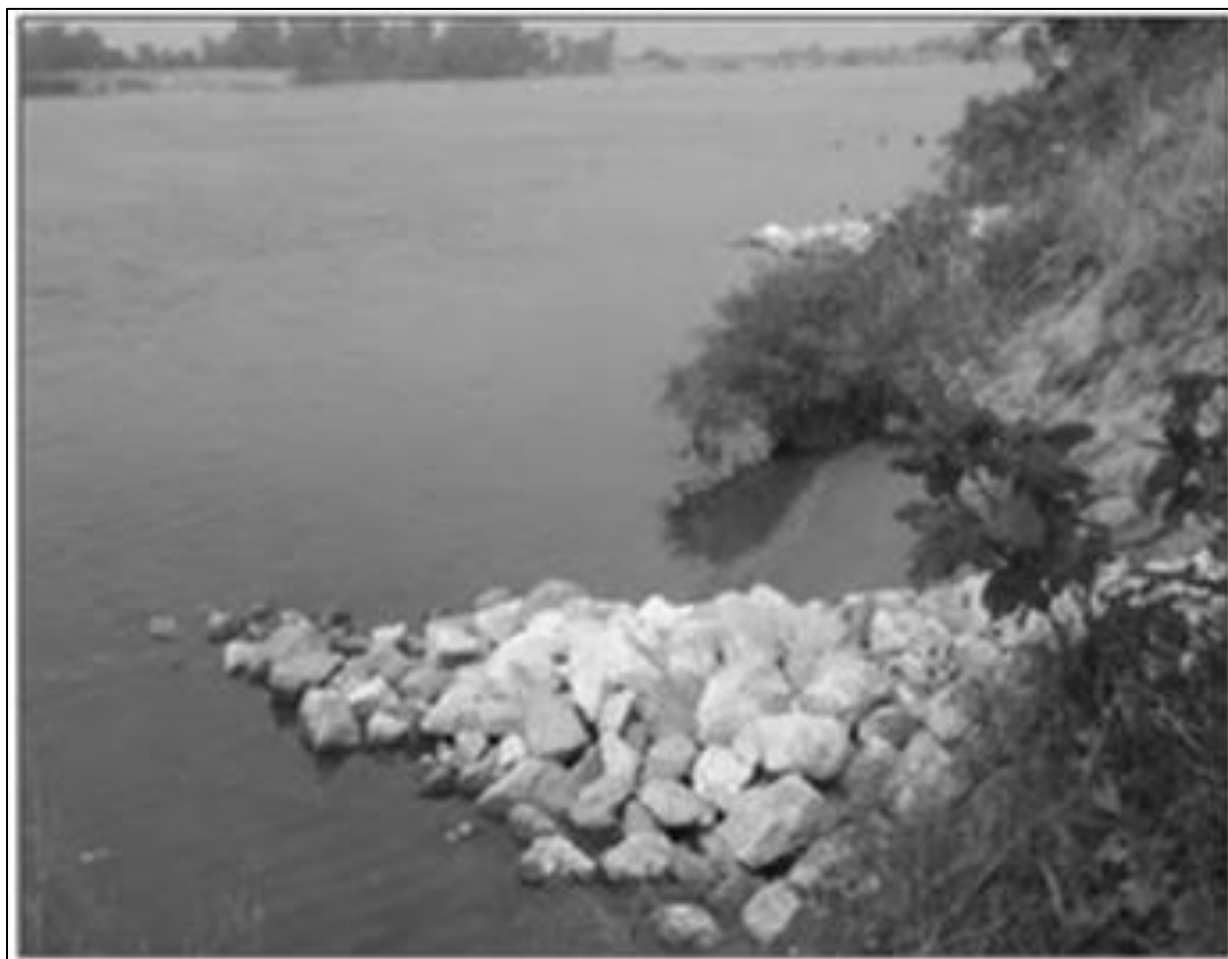
Figura 2.3-15 Epiuri pintendin arocamente, exemplu: eficient pe malul adiacent unui curent în mișcare (sursa: 2012 US Army Corps of Engineers, Upper Mississippi River Restoration Environmental Management Program - Capitolul 4 Shoreline Stabilization Technique Design Details)
