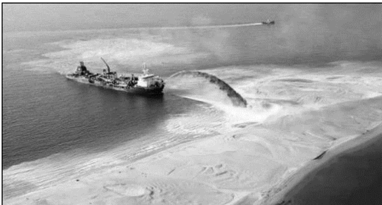
Figura 2.3-7 Dragare prin aspiratie si taiere
