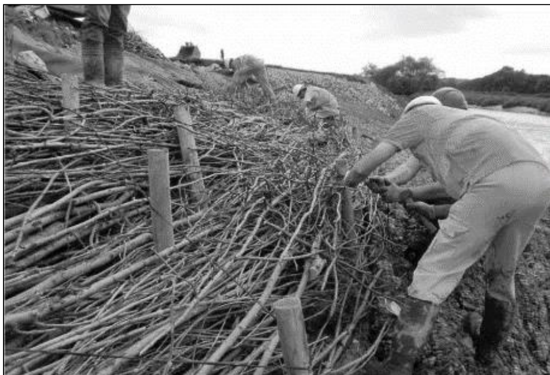
Figura 2.3-10 Instalare fascine
