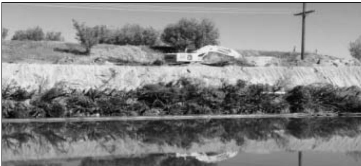
Figura 2.3-14 Exemplu de mal inierbat: arbusti si busteni pe o fundatie mica de anrocamente, cu material lemnos mort si butasi vii la nivelul apei; protectia malurilor si crearea diversitatii habitatelor (prin amabilitatea Lower Meander Project, Kootenai River)
