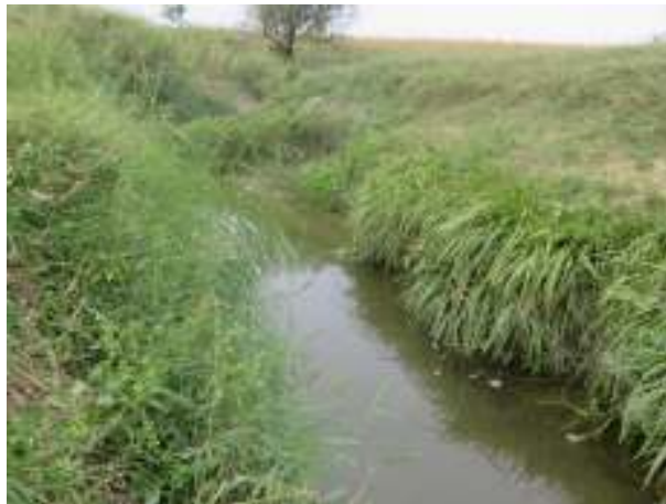
Foto 4. Aspect pârâul Răcăciuni în zona de intersecție cu proiectul
