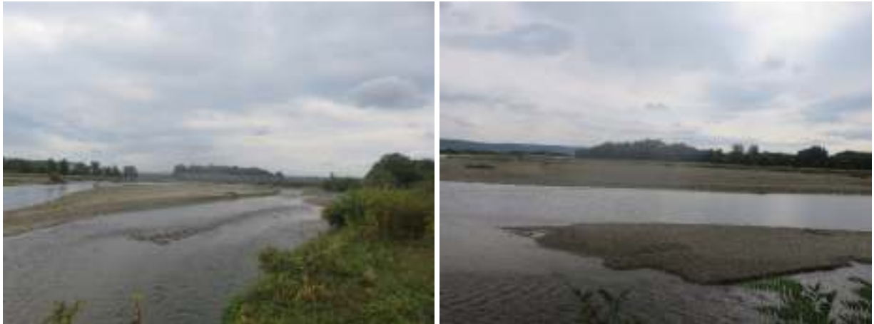
Foto 3. Aspect râul Trotuș în zona de intersecție cu proiectul
