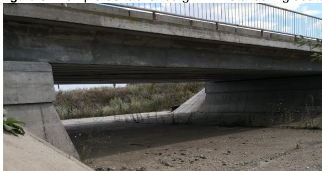
Figura 7. Exemplu grinzi metalice înglobate în beton
