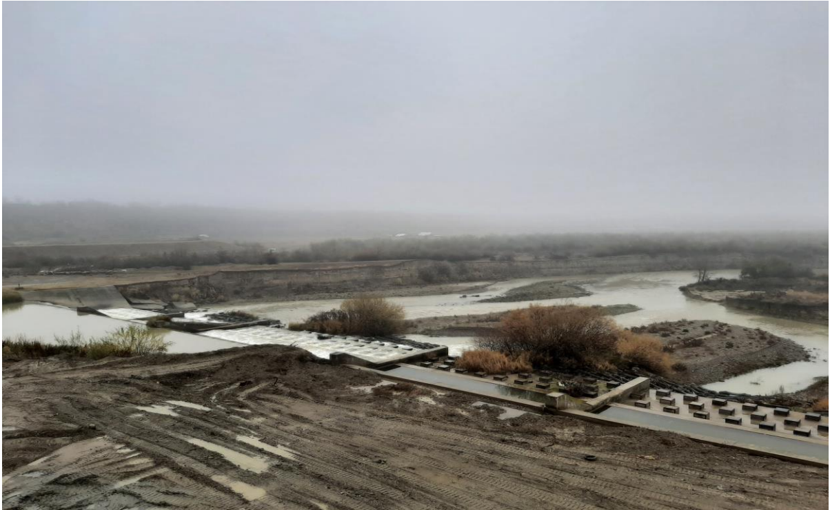
Prag de fund aval de podul de cale ferată peste râul Buzău
