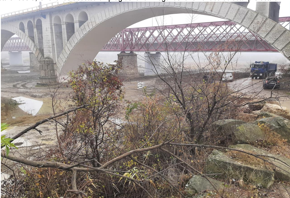
Figura 24 – Paralelism între cele trei poduri ce susțin infrastructuri de transport în interiorul ariilor Natura 2000 suprapuse ROSAC0103 și ROSPA0160 Lunca Buzăului (în plan apropiat podul de cale ferată din bolți gemene din beton armat ce face obiectul reparațiilor în cadrul proiectului)
