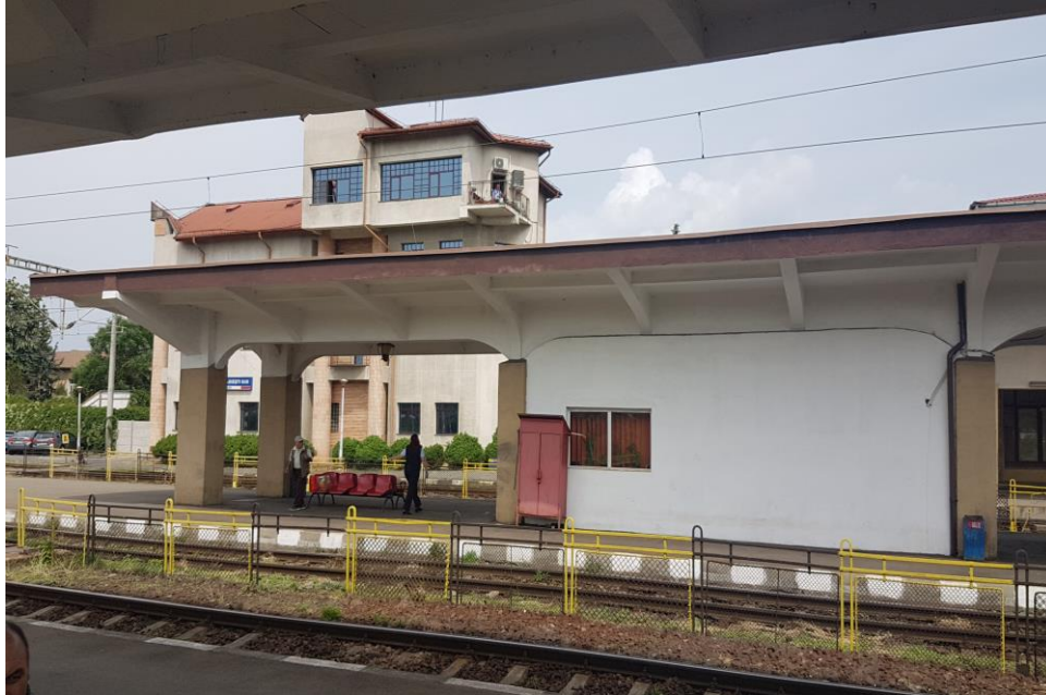
Stația de cale ferată Ploiești Sud
