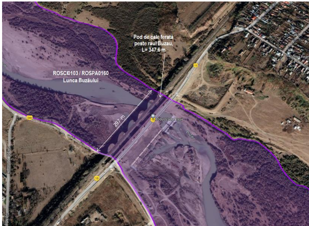
Figura 26 – Podul cu bolți gemene din beton peste râul Buzău
