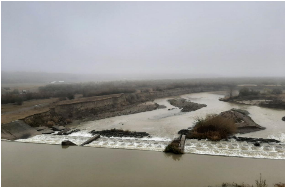
Prag de fund mal stânga aval de podul de cale ferată peste râul Buzău
