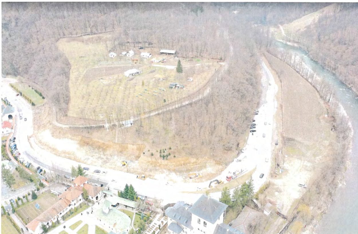
Fig. 5. Fotografie reamenajare sector km 106+220 - km 106+965 din zona Mănăstirii Lainici
